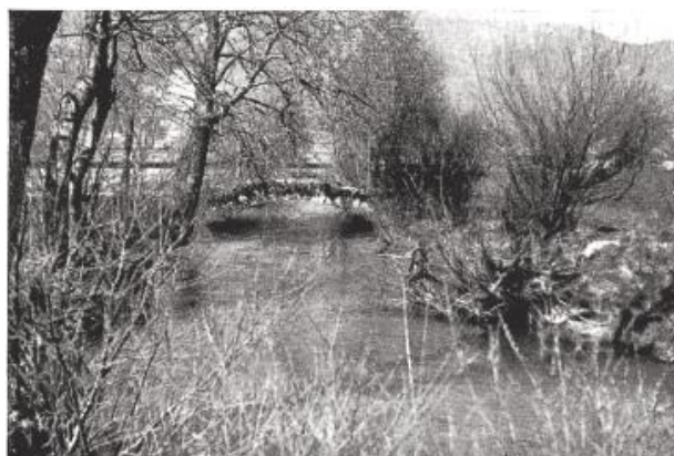
Abbildung 7: Dünner vor der Korrektion von 1933-1944 bei der alten Schleifbrücke östlich Oberbuchsiten. Abbildung aus [18].
