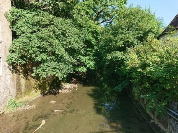
Foto 1: Brücke Äussere Klus, Blick gegen Fliessrichtung.
