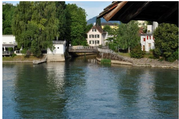
Foto 80: Mündung der Dünnern in die Aare Dünnern bei km 0.0, Blick gegen Fließrichtung.
