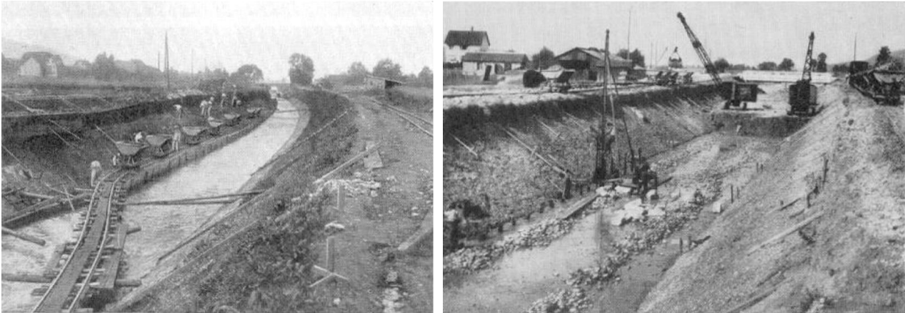
Abbildung 5: Bau des neuen Kanals in Handarbeit zwischen Rickenbach und Wangen (links) und mit Baggern bei Egerkingen (rechts).
