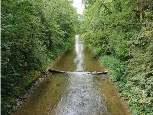
Abbildung 20: Kanalisiertes Gerinne mit Schwelle km 9.38 Egerkingen.
