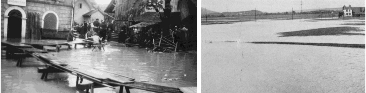
Abbildung 3: Überflutetes Schulhaus Unterdorf in Oensingen (links); Überschwemmtes Kulturland zwischen Egerkingen und Härkingen (rechts).
