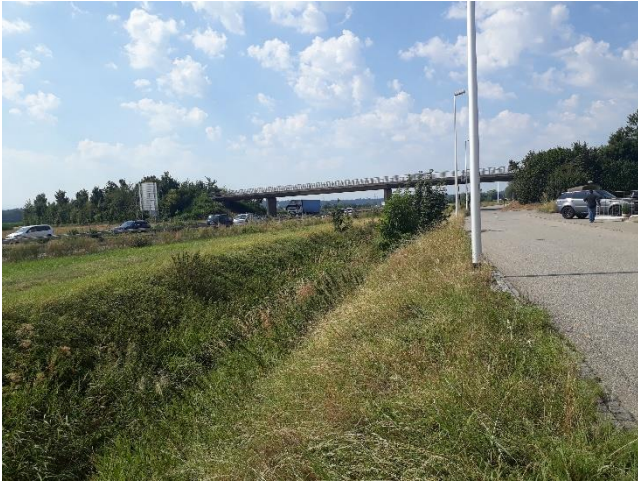
Abbildung 87: Bipperbach zwischen der Autobahn A1 und der Ostringstrasse (Blick gegen Fliessrichtung).
