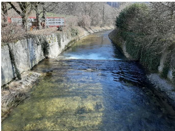
Abbildung 18: Uferverbau und Schwelle km 18.575, Oensingen Brücke Klusstrasse.
