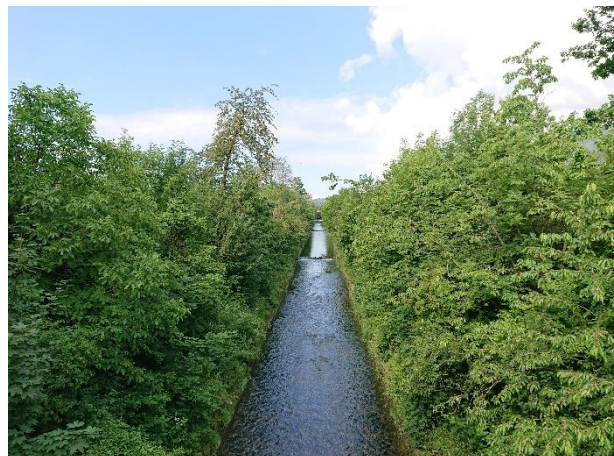
Abbildung 19: Kanalisiertes Gerinne Km 16.145, Oensingen, Brücke Breitfeldstrasse.
