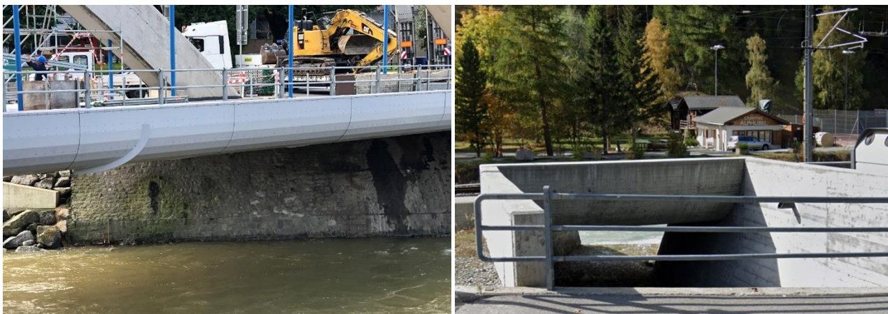
Abbildung 73: Beispiele von Brücken mit Staukränzen und Verschalung der Untersicht (links: Brücke in Emmenbrücke/Luzern über der kleinen Emme; rechts: Brücke in Täsch über den Täschbach vor der Mündung in die Vispa).
