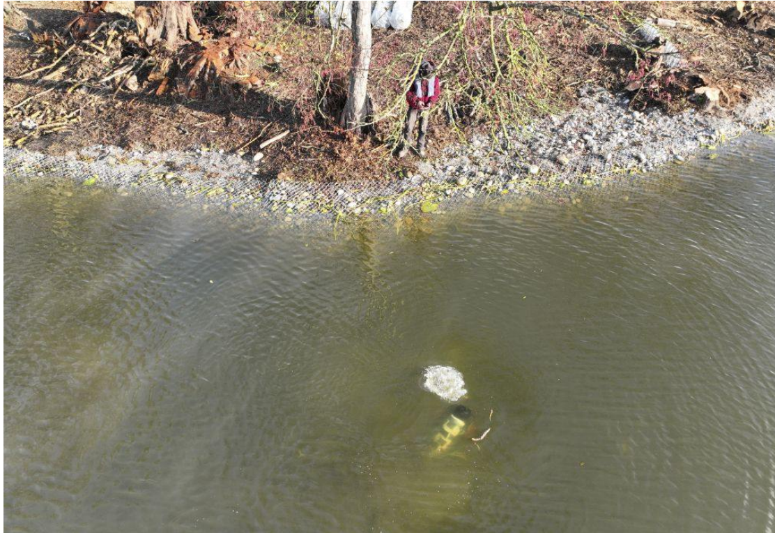
((Abb. 3)) Über dem ausgeebneten Uferbereich wurde eine erste Bahn Nagetiergitter installiert. An diese anschliessend verlegte die Tauchequipe weitere Gitterbahnen auf den Seegrund. (Bild: Archäologischer Dienst des Kantons Bern, Johannes Reich)
