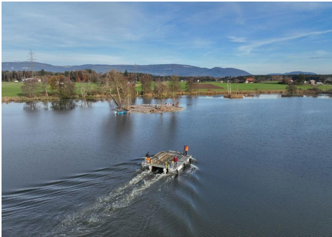
((Abb. 4)) Das Gitter wurde am Seegrund mit einer Deckschicht aus Kies überdeckt. Dabei kam ein Katamaran mit Klappboden zum Einsatz. (Bild: Archäologischer Dienst des Kantons Bern, Johannes Reich)
