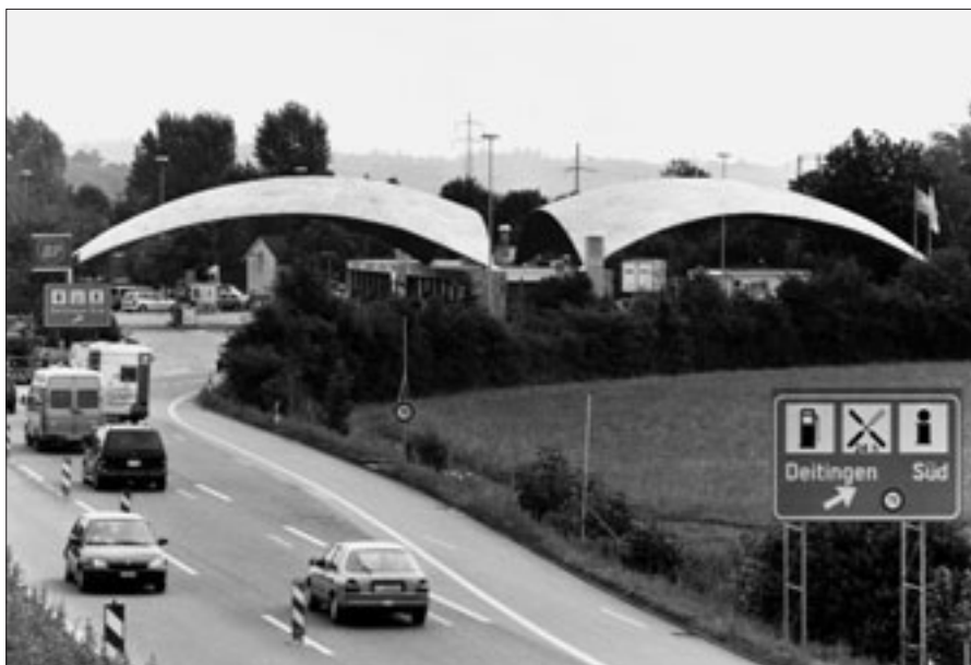
Deitingen, Autobahnraststätte Deitingen Süd, Ansicht von Westen.
