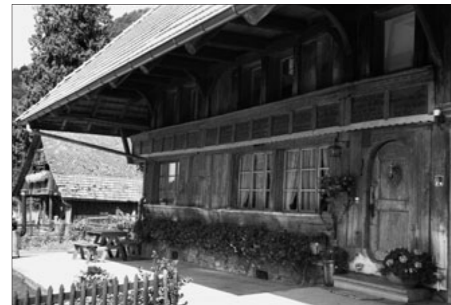
Abb. 1 Balm bei Messen, Bauernhaus Moser/Rätz, Wohnteil mit den bemalten Holztafeln über den Erdgeschossfenstern, nach der Restaurierung 1999.
