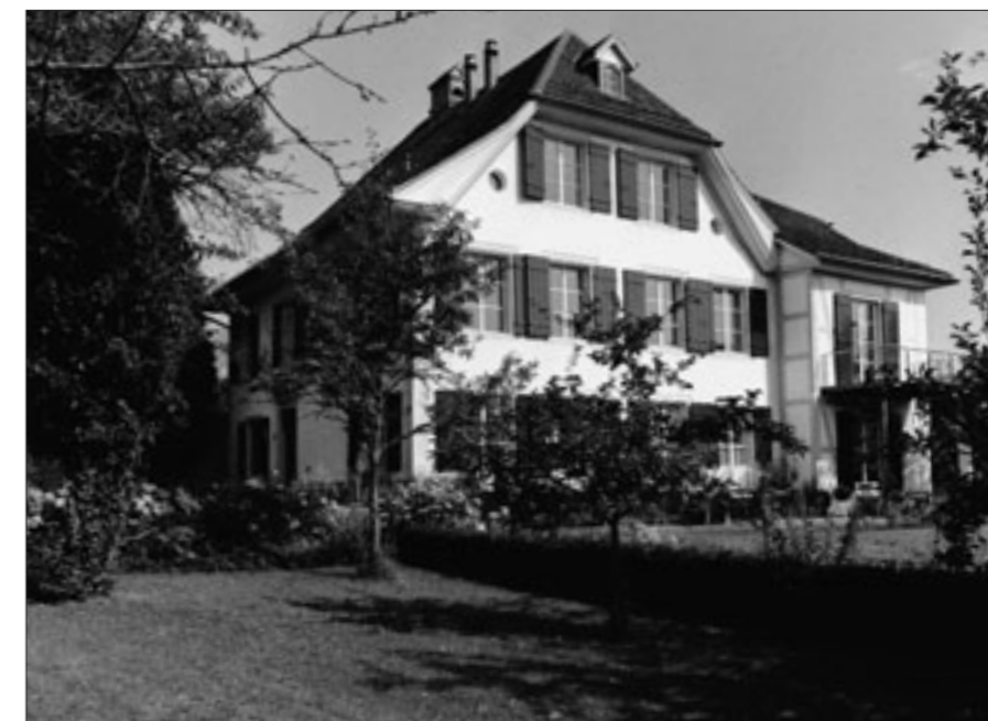
Abb. 1 Solothurn, «Josephshof», Gartenseite von Südwesten nach der Renovation von 1999.
