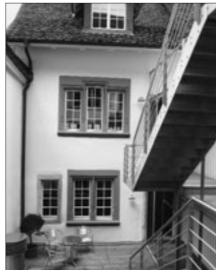
Abb. 8 Hoffassade des Hinterhauses mit reich instrumentierten Fenstergewänden aus Sandstein aus dem frühen 17. Jahrhundert. Links Zustand nach dem Brand von 1988, rechts nach der Restaurierung von 1998.
