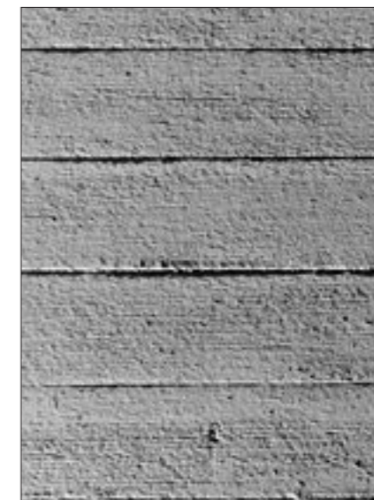
Abb. 6 Südfassade, Spritzbeton mit nachgeahmtem Schalungsbild.
