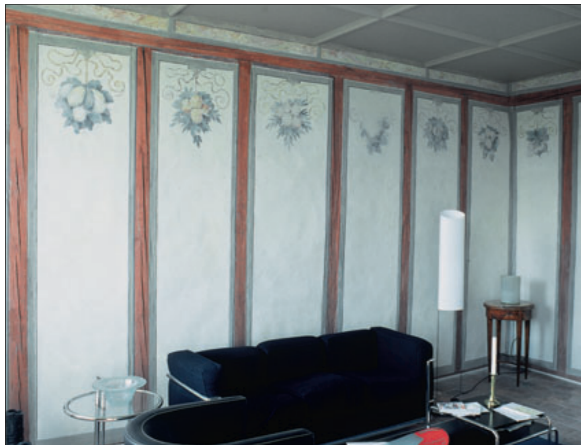
Abb. 3 Saal im Dachgeschoss mit den 1998/99 freigelegten und restaurierten Dekorationsmalereien aus der Bauzeit um 1646.
