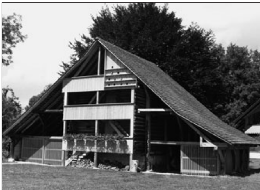
Deitingen, Speicher im Wylhof, Ansicht von Süden, nach der Restaurierung 1999.
