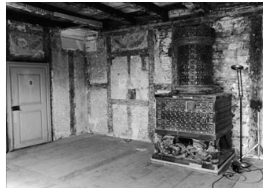
Abb. 1 Oensingen, Neu-Bechburg, Blick ins «Stockerzimmer». Zustand nach der vollständigen Freilegung der dekorativen Ausmalung. Noch steht der im späten 19. Jahrhundert eingebaute Turmofen.
