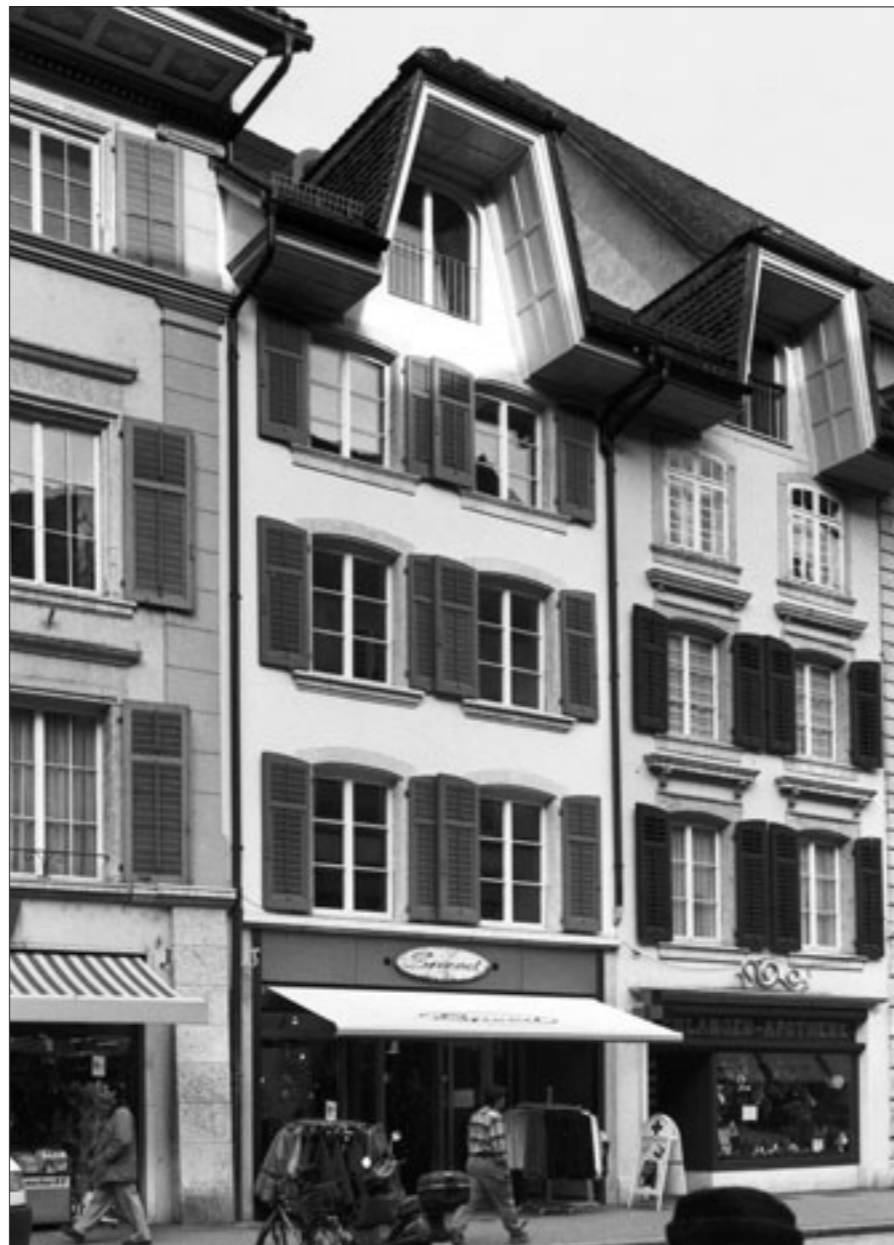
Abb. 1 Solothurn, links das Vorderhaus Gurzelgasse 34, Fassade nach der Renovation von 1998. Rechts das Haus Gurzelgasse 32.
