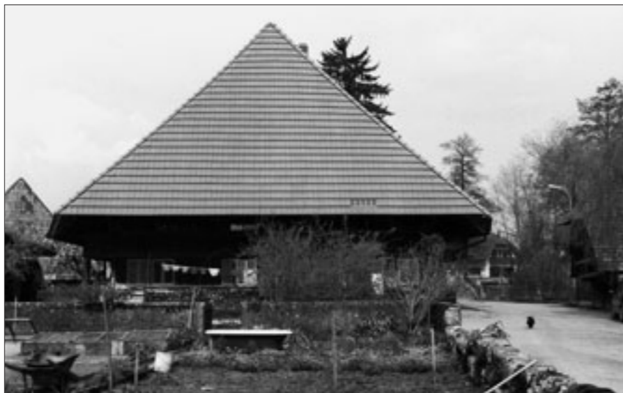
Biberist, Bauernhaus Moosstrasse 14, Ansicht von Südwesten, nach der Neueindeckung des Daches 1999.
