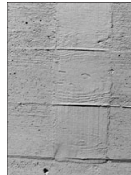
Abb. 4 Ostfassade, reprofilierte Partie.
