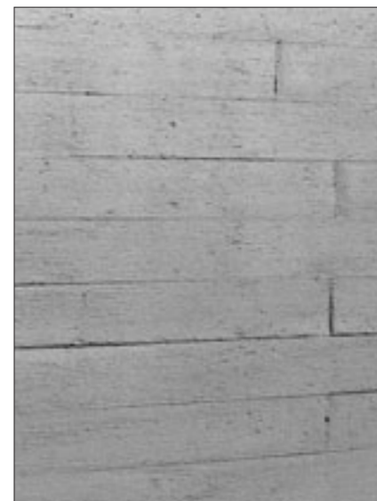
Abb. 3 Ostfassade, originale Schalungsstruktur, nach der Restaurierung 1999.
