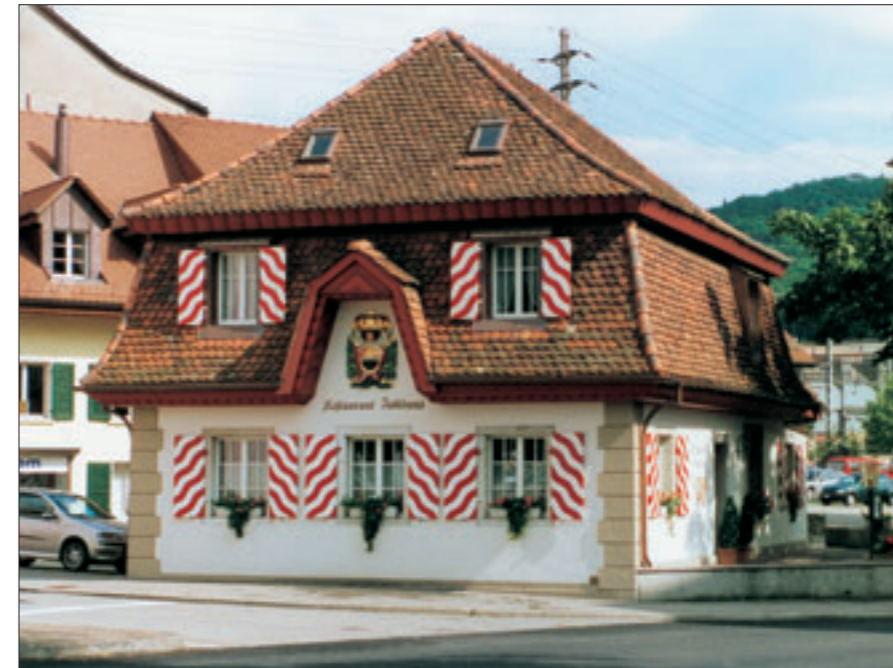
Olten, Restaurant «Zollhaus», Ansicht von Osten, nach der Restaurierung 1999.
