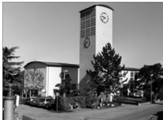
Abb. 1 Dornach, St. Mauritius, Ansicht von Südosten, nach der Restaurierung 1999.
