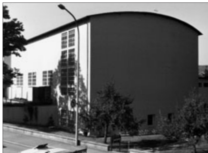
Abb. 2 Ansicht von Nordosten, nach der Restaurierung 1999.
