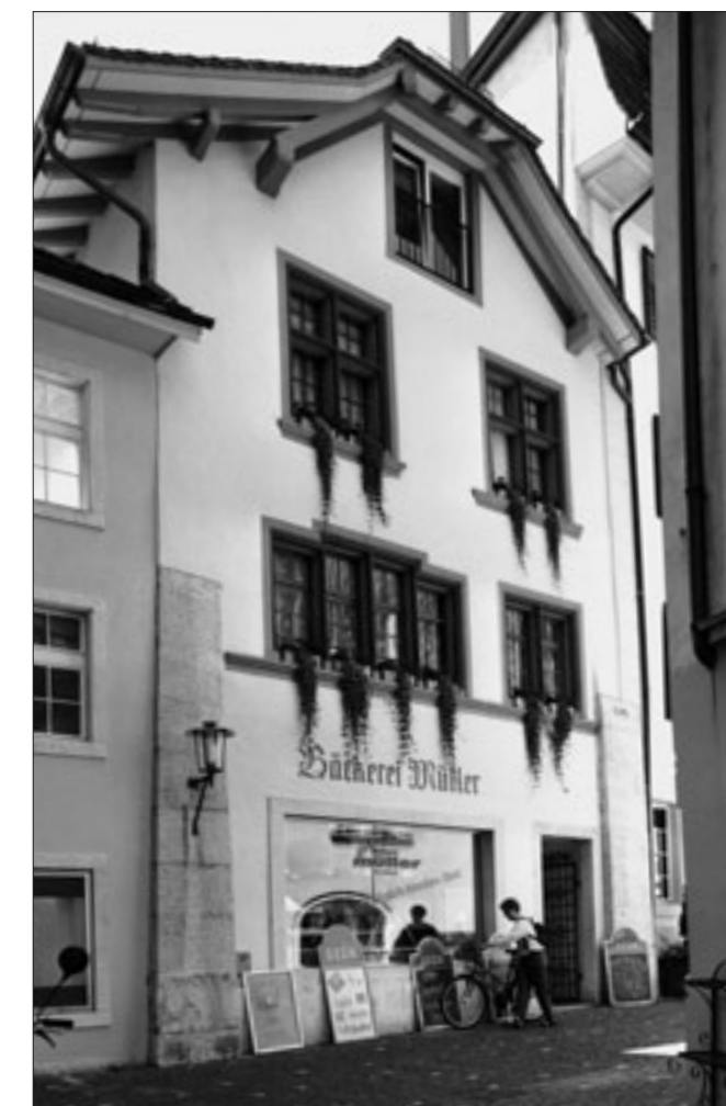
Abb. 2 Die Gassenfassade nach der Renovation von 1999 mit dem rekonstruierten Aufzugsgiebel und der wieder hergestellten Farbfassung der Fenstergewände.
