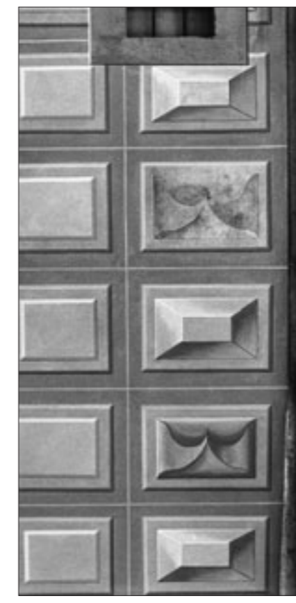
Abb. 5 Neufassung der Quadermalerei mit restaurierten und rekonstruierten Eckquadern.
