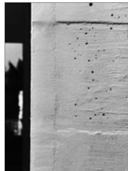
Abb. 5 Südostecke, ursprüngliche Schalungsstruktur der Ostfassade (rechts) und neue Überdeckung der Südfassade mit Spritzbeton (links).
