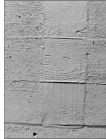
Abb. 4 Ostfassade, reprofilierte Partie.
