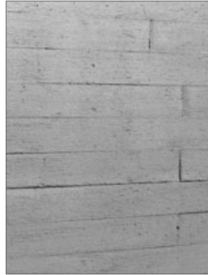
Abb. 3 Ostfassade, originale Schalungsstruktur, nach der Restaurierung 1999.
