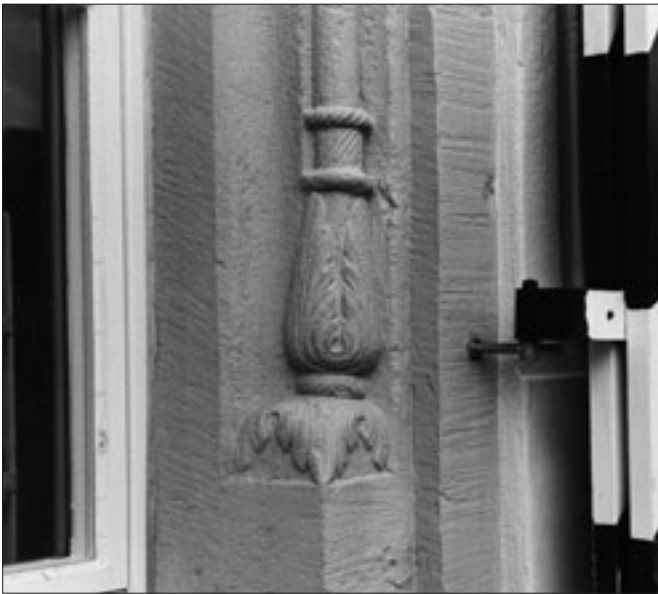
Abb. 4 Profil und Zierformen an einem Fenstergewände von 1587 am alten Schützenhaus in Solothurn.
