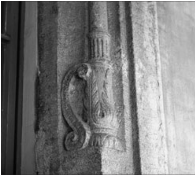
Abb. 3 Profil und Zierformen an einem Fenstergewände im 2. Obergeschoss.
