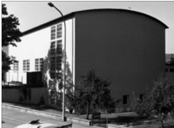
Abb. 2 Ansicht von Nordosten, nach der Restaurierung 1999.
