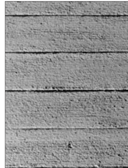
Abb. 6 Südfassade, Spritzbeton mit nachgeahmtem Schalungsbild.
