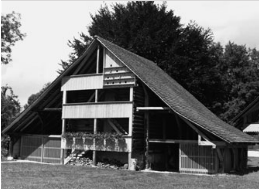
Deitingen, Speicher im Wylihof, Ansicht von Süden, nach der Restaurierung 1999.
