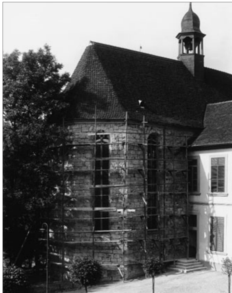
Abb. 41 Ansicht des Chores von Nordosten, 1922 anlässlich einer Aussenrenovation. Das Tuffsteinmauerwerk rechnete ursprünglich mit Sicht.
