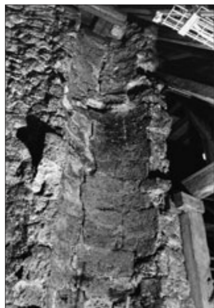
Abb. 34 Überreste der Wendeltreppe, die einst vom Lettner in den Estrich hinaufführte. Partie in der nördlichen Chormauer, im Estrichbereich des ehemaligen Refektoriums.
