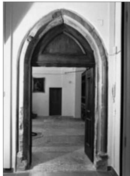
Abb. 33 Türöffnung vom ehemaligen Kreuzgang in den Chor, 1481 erneuert. Ansicht von der heutigen Sakristei aus.
