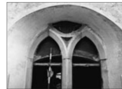
Abb. 43 Chor, Fenster Süd, Masswerkabschluss. Zustand während der Restaurierung, 1995.
