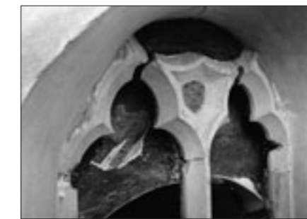
Abb. 45 Chor, Fenster Südost, Masswerkabschluss. Zustand während der Restaurierung, 1995. Durch Bewegungen im Mauerwerk sind die Werkstücke voneinander gewichen.
