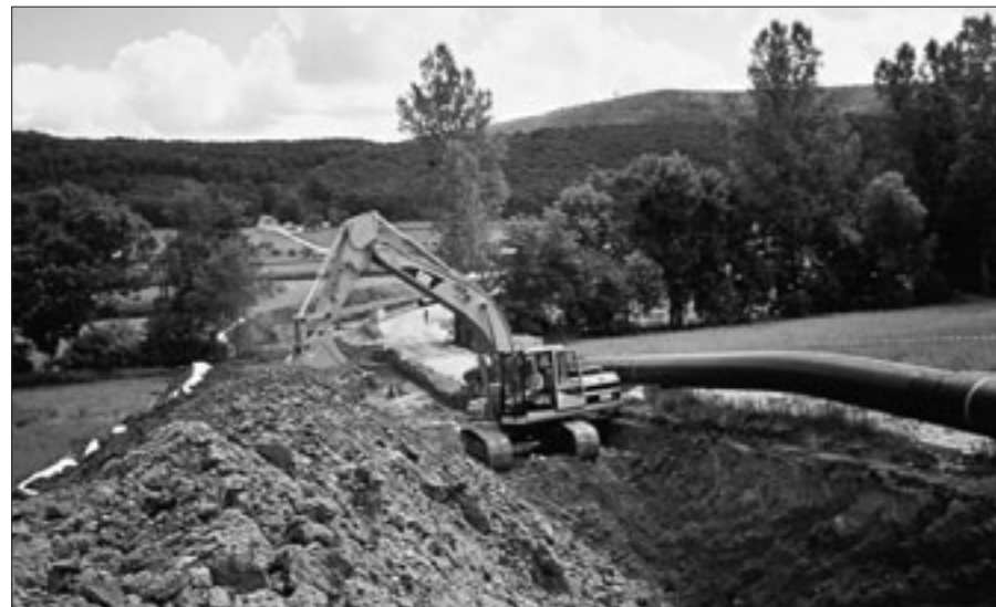
Abb. 2 Aushubarbeiten an der Transitgasleitung Rodersdorf-Lostorf bei der mittelalterlichen Wüstung Biedersdorf, westlich von Rodersdorf.
