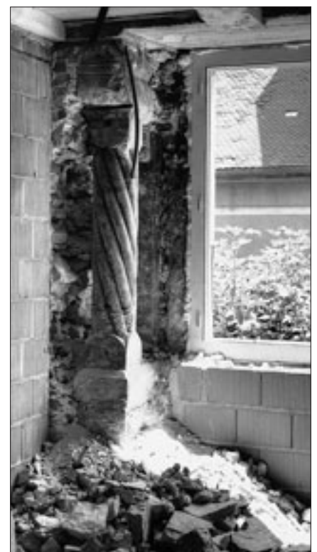
Abb. 1–3 Solothurn, Haus Klosterplatz 6, 1. Obergeschoss, Zimmer Südwest. Fenstersäule während der Freilegung 1989.
