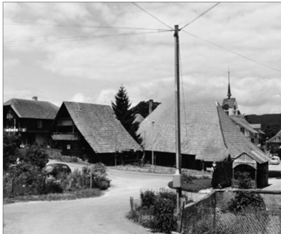
Abb. 1 Messen, Bauernhaus und Speicher Spielmann vor dem Abbruch.
