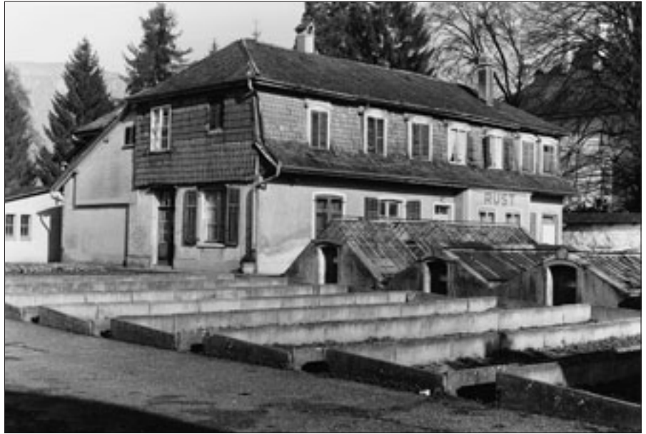
Abb. 3 Die ehemalige Orangerie Baselstrasse 51 im Zustand 1995.
