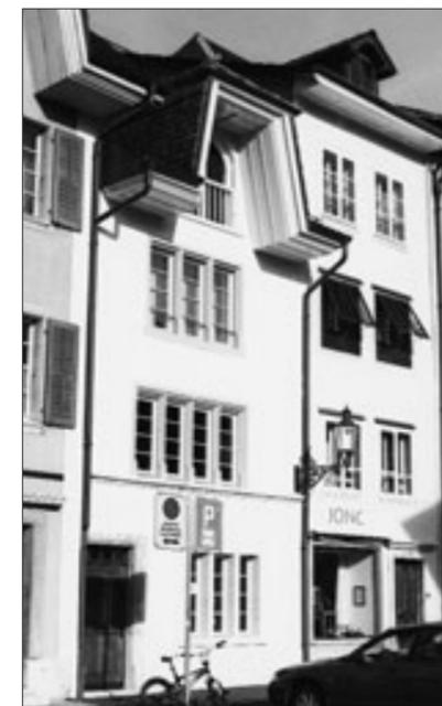
Abb. 2 Fassade nach der Renovation. Die rekonstruktive Rückführung in einen älteren Zustand ist nur beim Fenster im ersten Obergeschoss wirklich geglückt.
