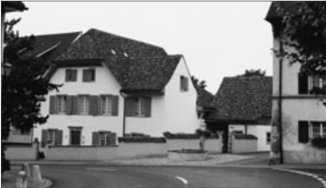
Abb. 2 ...und nach der Restaurierung von 2000/2001.
