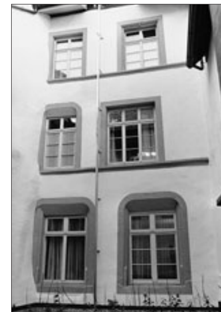
Abb. 2 ...und nach der Restaurierung von 2001.
