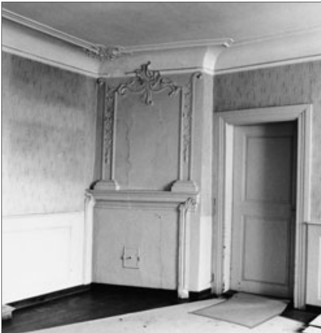
Abb. 3 1. OG Zimmer Nordwest. Ehemalige Feuerstelle zum Kachelofen, Zustand vor der Restaurierung.
