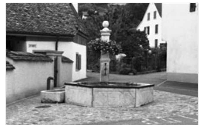
Abb. 2 ...und nach der Restaurierung von 2002.
