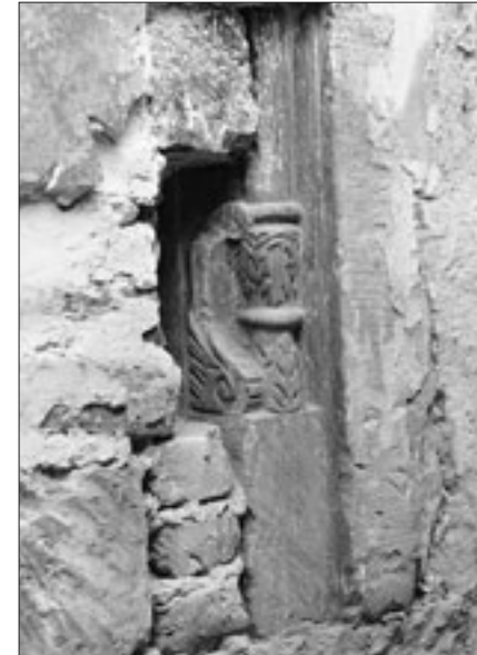
Abb. 8 Profiltotlauf am ehemaligen Dreierfenster im 2. Obergeschoss des Hinterhauses, 16. Jahrhundert.
