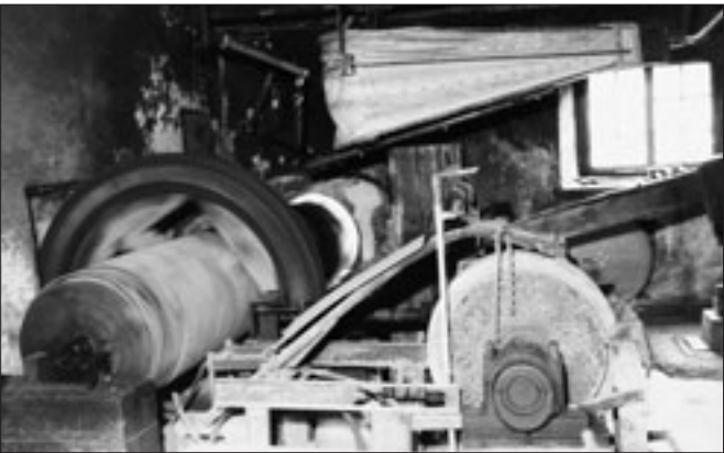
Abb. 2 Blick in den Schmiederaum; über der Schmitte der Blasebalg, der vom kleineren Wasserrad betrieben wird.
