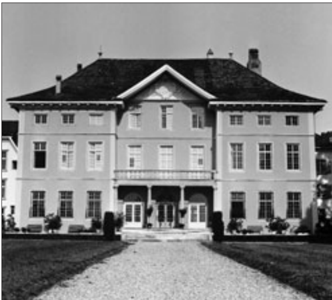
Abb. 3 ...und nach der Renovation von 2002.
