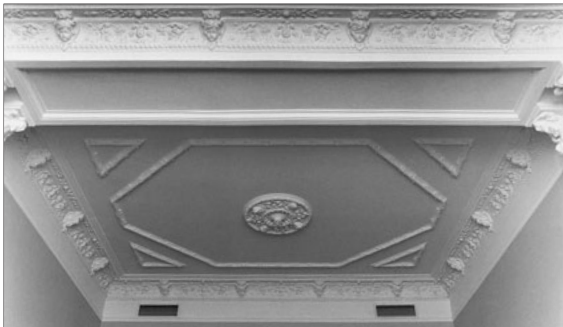
Abb. 3 ...und nach der Restaurierung, 2003.
