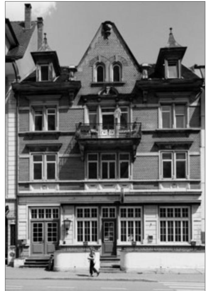
Abb. 1 Olten, «Salmen» Hauptfassade nach der Ringstrasse.
