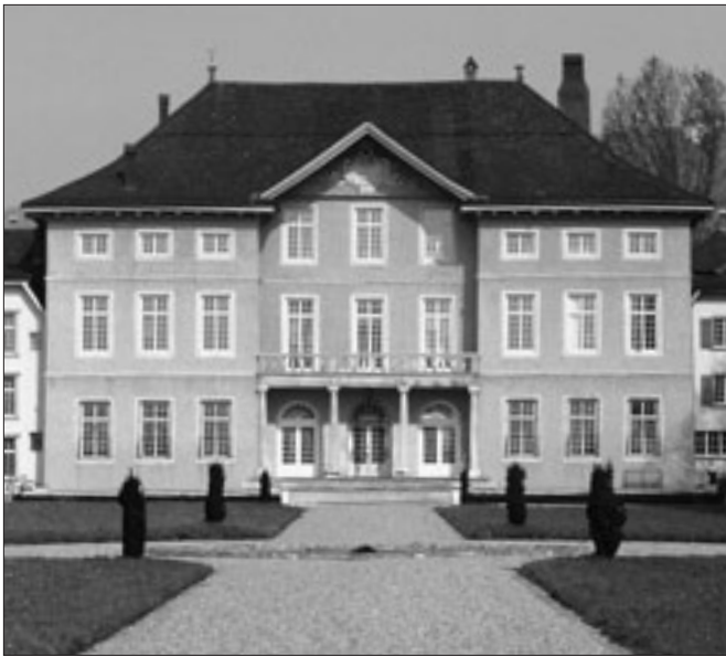
Abb. 2 ...nach der Renovation von 1977...
