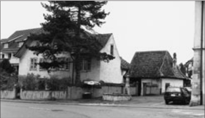
Abb. 1 Dornach, altes Pfarrhaus vor der Restaurierung, 1998...
