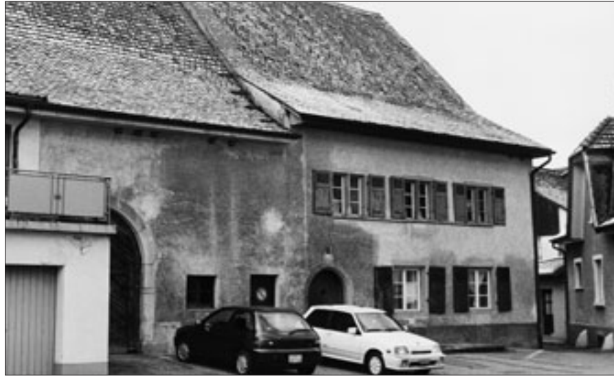
Abb. 1 Dornach, Hauptstrasse 30/32, Zustand 2000...
