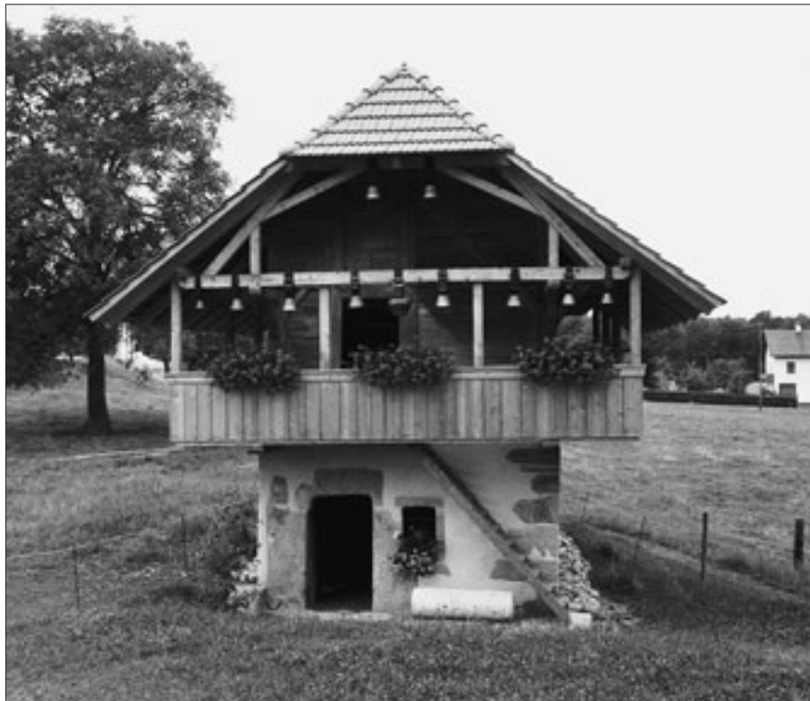
Lütterswil/Gächliwil, Speicher Andres nach der Instandstellung.
