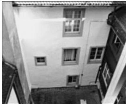
Abb. 5 ...und nach der Restaurierung von 2001.
