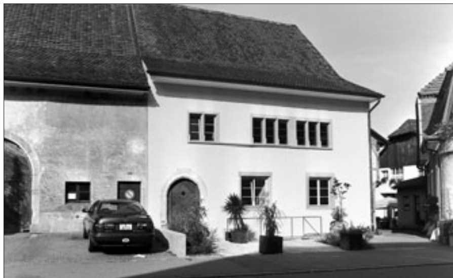
Abb. 2 ...und nach der Renovation, 2002.
