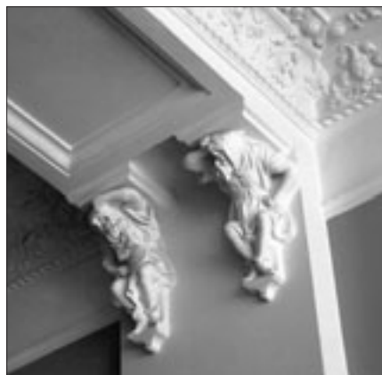
Abb. 4 Detail Konsole am Unterzug in der Raummitte.
