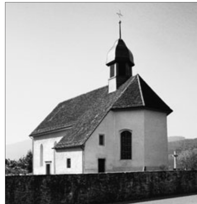
Abb. 5 Aussenansicht von Südosten nach der Restaurierung von 2001/02.
