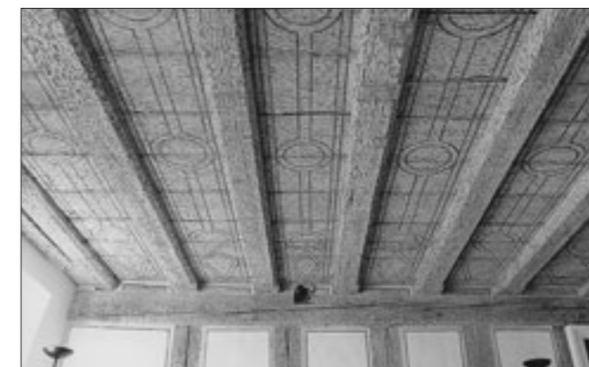
Abb. 2 Die Balkendecke nach der Restaurierung von 2003.
