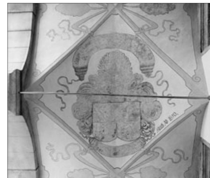
Abb. 6 ... und nach der Restaurierung von 2003.
