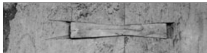
Abb. 1 Detail einer Brettrückseite. Die stumpf verleimten Bretter sind mit einem Verbindungselement gesichert.
