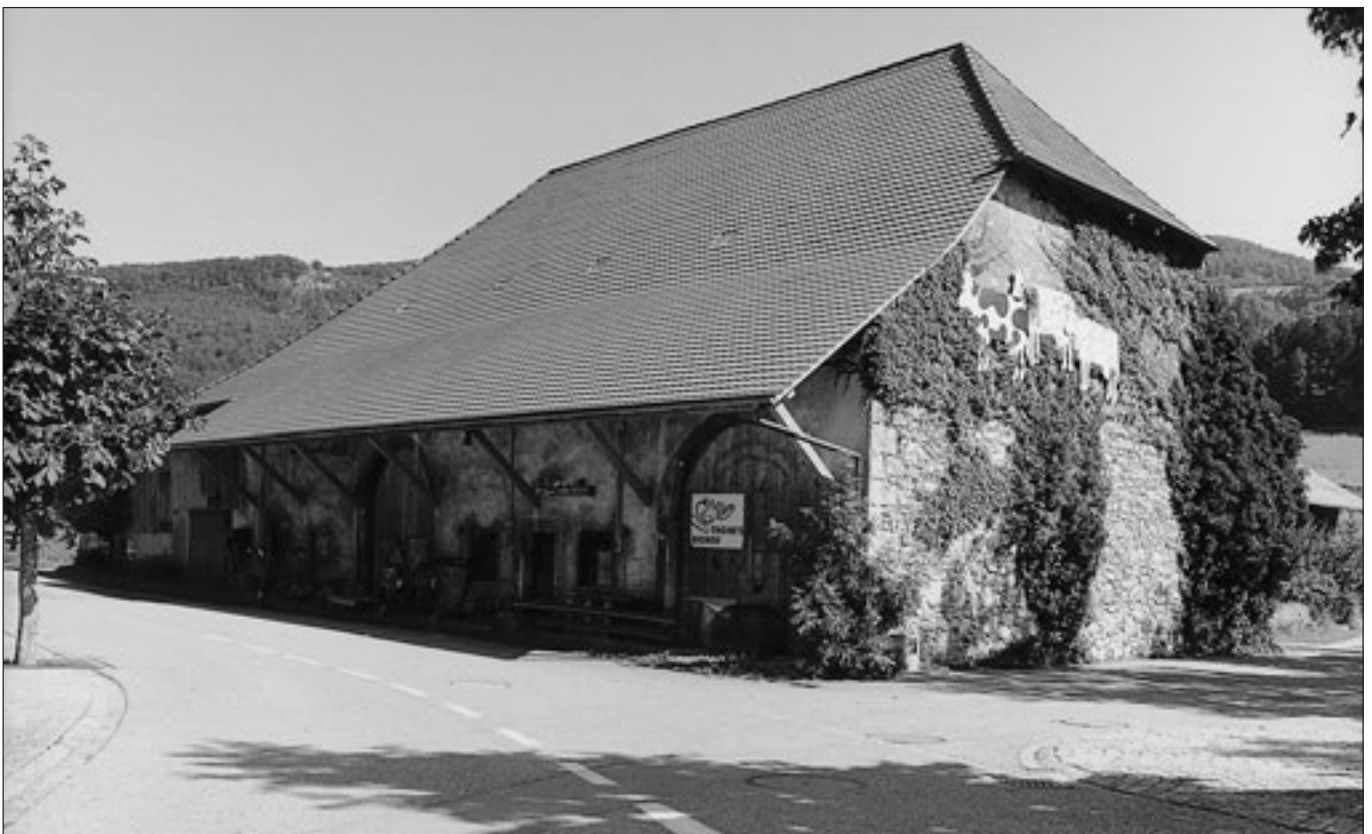
Abb. 1 Balsthal-St. Wolfgang, ehemalige Schlossscheune nach der Neueindeckung des Daches 2003, Ansicht von Nordosten.
