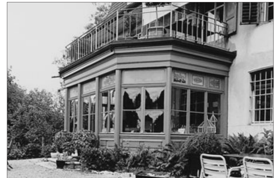
Abb. 2 ...und nach der Restaurierung 2003.
