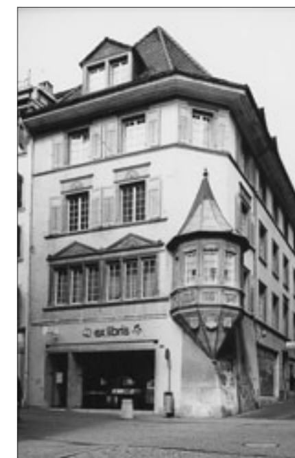
Abb. 2 ... und 2003 im Zustand nach den Umbauten von 1920 und später.
