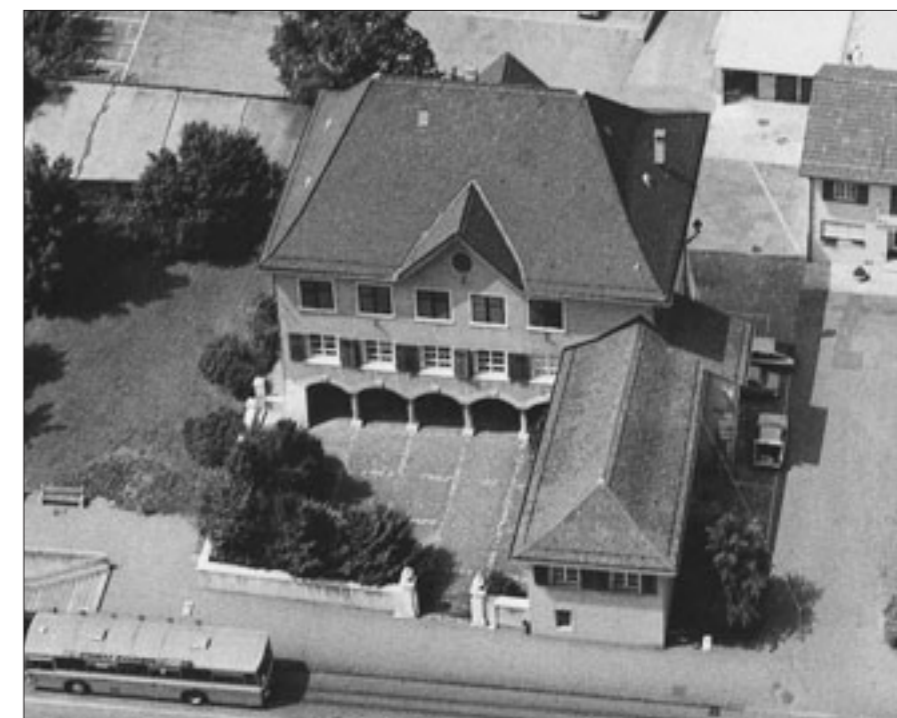
Abb. 1 Das Haus Baselstrasse 7, Flugaufnahme 1983.
