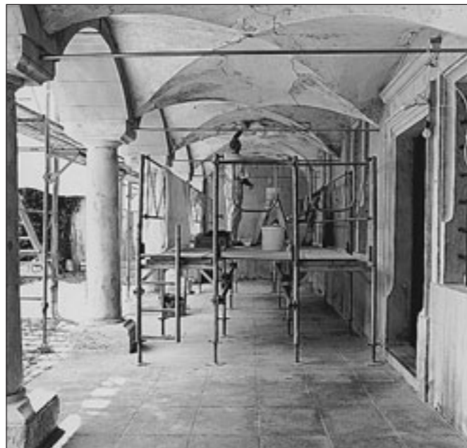
Abb. 3 Die Loggia während den Restaurierungsarbeiten 2003, Blick nach Westen.
