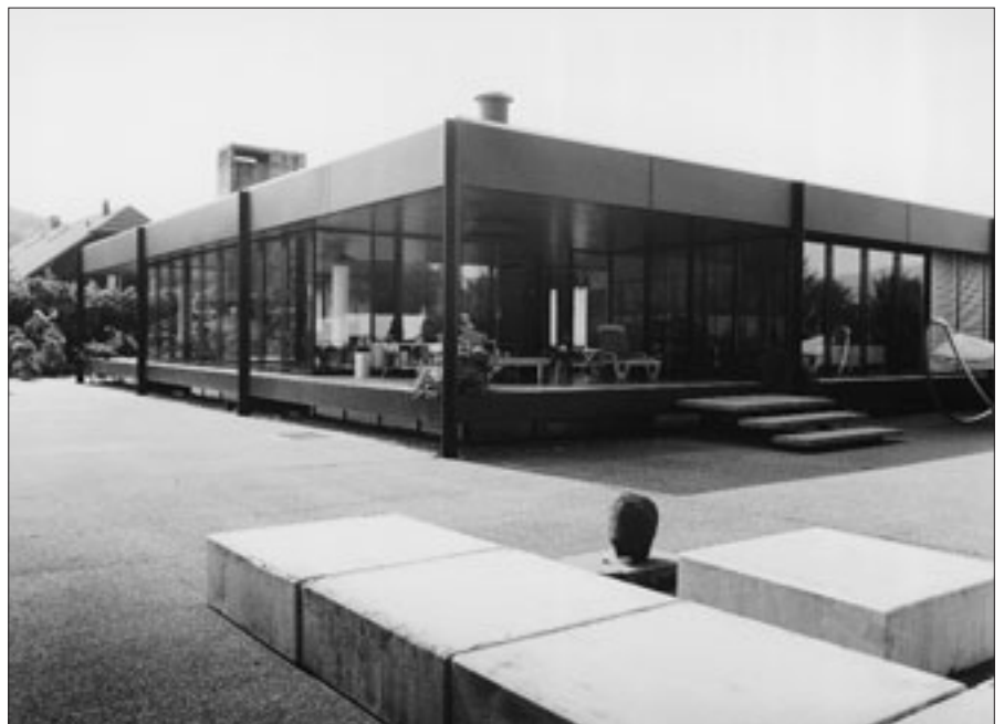
Abb. 1 Hans Zaugg, Haus Süess (1965), Starrkirch-Wil. Ansicht von Osten 2005.
