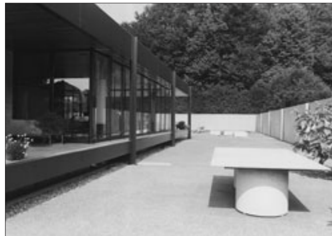
Abb. 13 Hans Zaugg, Haus Süess (1965), Starrkirch-Wil. Südwestansicht mit Terrassenhof 2005.
