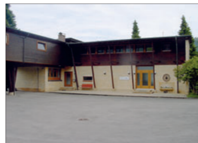
Abb. 5 Hannes Meyer, Genossenschaftliches Kinderheim Mümliswil (1937–39), Südflügel mit Haupteingang, Aufnahme vom 11. Juni 2004 (in: Privat-Archiv).
