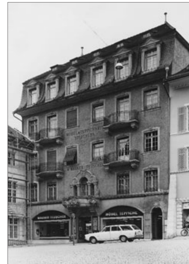
Abb. 5 Solothurn, Hauptgasse 67. Zustand nach der Aufstockung und der Neugestaltung der Fassade von 1916.
