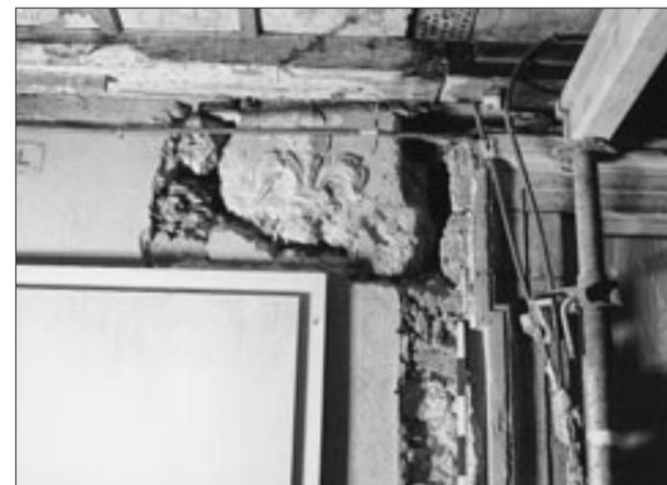
**Abb. 5** Befund über der ehemaligen Tür zum Treppenturm. Der lilienförmige Dekor ist in ein Werkstück aus Hauteriveststein gehauen, er ist wahrscheinlich Teil einer früheren Türrahmung aus der Bauzeit von 1580. Rechts die um die Mitte des 17. Jahrhunderts neu erstellte Tür zum Treppenturm.
