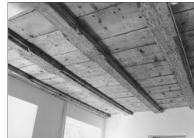
**Abb. 6** Die Decke über dem Foyer mit fein profilierten Balken und eingeschobenem Blindboden aus überfärbten, glatt gehobelten Brettern stammt aus der Bauzeit von 1580. Zustand nach der Freilegung und Reinigung.
