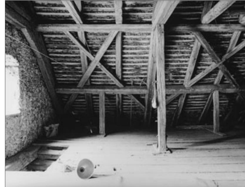
**Abb. 12** Die weitgehend intakt erhaltene Dachkonstruktion mit sogenannten «Anderskreuzen», die als Windverstrebung dienen. Der liegende Dachstuhl ist laut Arbeitsvertrag 1594/95 von Wer(n)li Meyer aus Erschwil verfertigt worden. Zustand 1999.
