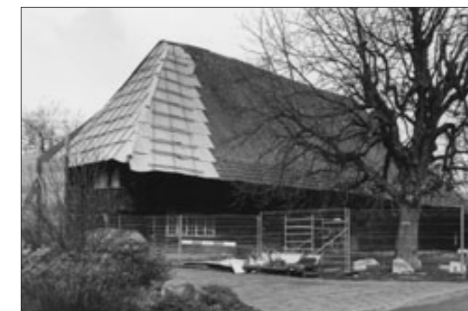
Abb. 2 Zuchwil, Gasserhaus, Ansicht von Südwesten 1998.
