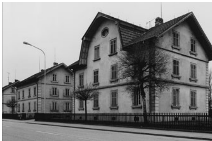
Abb. 1, 2 Gerlafingen, Biberiststrasse 17–29, Arbeiterhäuser von Roll-Werke vor dem Abbruch.
