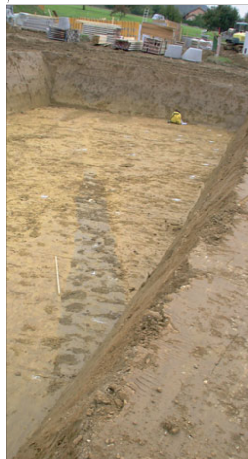
Abb. 1 Die ausgehobene Jauchegrube mit der dunklen Grabenverfärbung, im Hintergrund die Verschalung des Wohnhauses.
