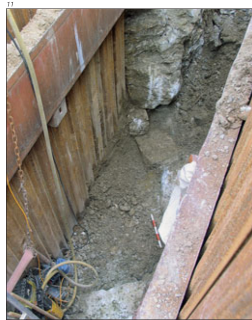
Abb. 11 Hauptbahnhofstrasse, Kanalisation 2005. Die Schanzenmauer verläuft quer durch den Leitungsgaben (im Hintergrund), rechtwinklig dazu ein Stützpfiler (im Vordergrund). Gegen Osten.
