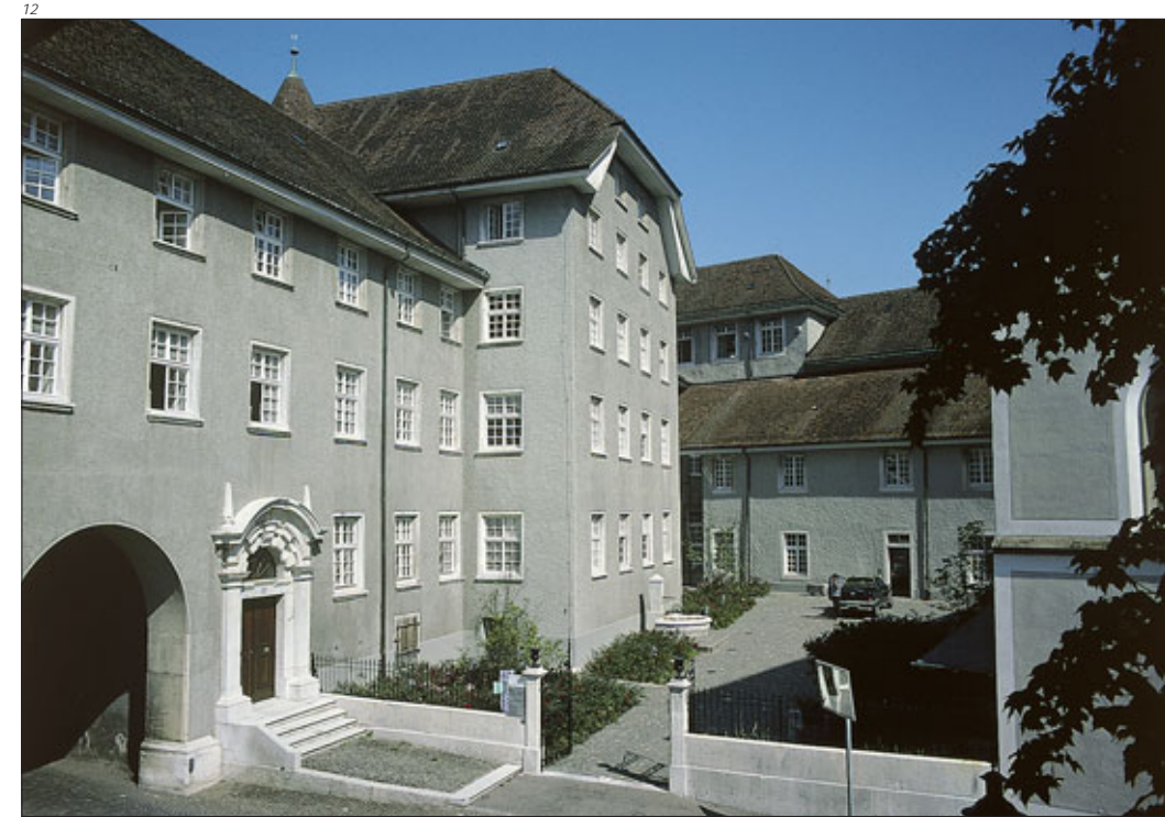
Abb. 12 Das 1665/66 errichtete neue Konventgebäude des ehemaligen Klosters, heute «Franziskanerhof» genannt. Zustand 2006.
