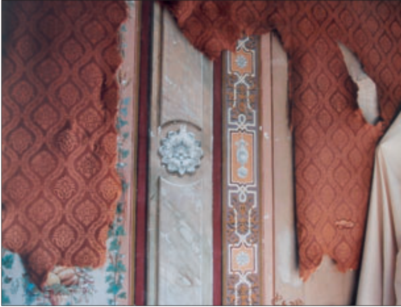
Abb. 20 Die westliche Veranda während der Entfernung von nachträglich angebrachten Stofftapeten. Darunter kommen bauzeitliche Dekorationsmalereien zum Vorschein.
