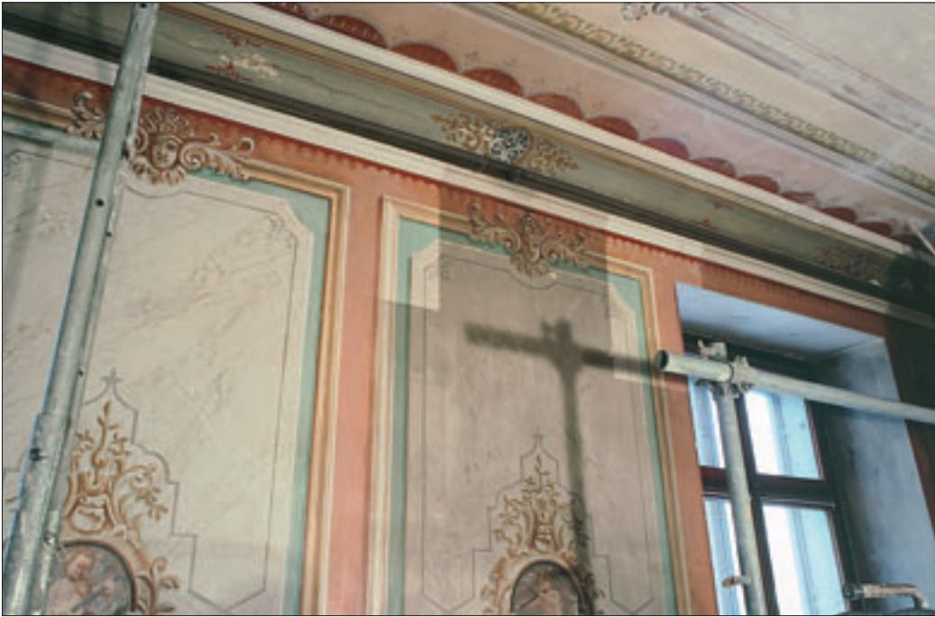
Abb. 16/17 Das Treppenhaus während der Restaurierung 2005. Deutlich sind die gereinigten von den verschmutzten Stellen zu unterscheiden.
