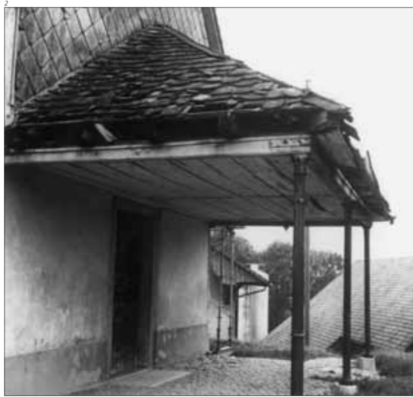
Abb. 2 Das Vorzeichen mit den gusseisernen Säulen von 1877 wurde bei der Renovation von 1974/75 durch das heute noch bestehende Pultdach mit Steinsäulen ersetzt.
