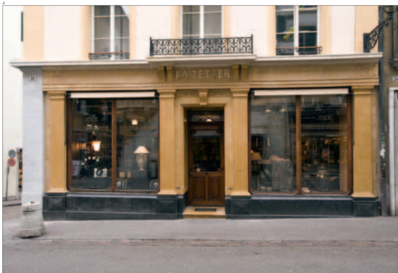
Abb. 4 Ladenfront nach der Restaurierung 2008.
