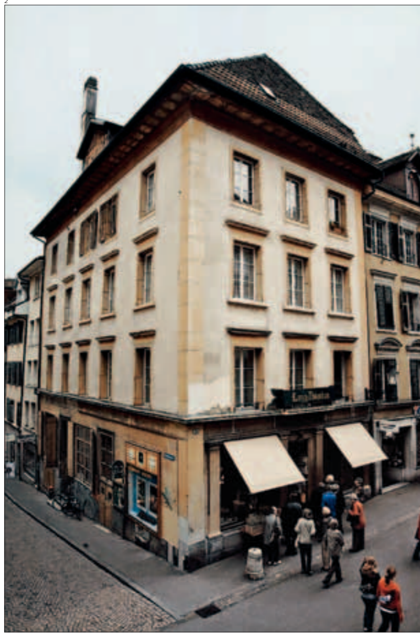
Abb. 2 Zustand vor der Restaurierung 2008.
