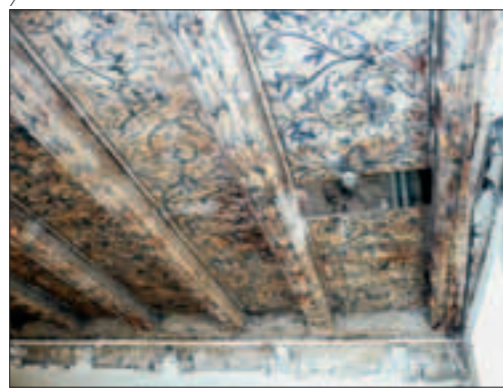
Abb. 7–9 Südstube, 3. Obergeschoss. Bemalte Balkendecke, Malerei um 1680/90. Zustand vor der Restaurierung.
