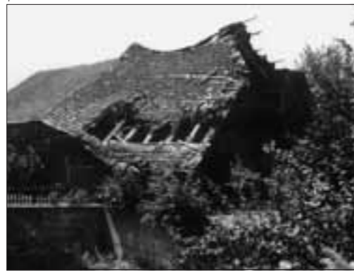
Abb. 1 Aetingen, Speicher Moosgasse 5, vor der Sanierung 2008.
