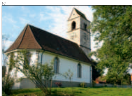
Abb. 10 Lüsslingen, Kirchofmauer um die ref. Pfarrkirche, nach der Restaurierung 2008.
