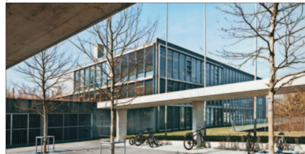
Abb. 1 Olten, Engelbergstrasse 60–64, Sälischulhaus. Das von Alfons Barth und Hans Zaugg von 1964 bis 1968 erbaute Sälis- schulhaus ist ein charakteristi- scher Bau dieser bedeutenden Architekten und zeichnet sich durch seine Erhaltung in weitgehend ursprünglicher Form aus. Es wurde im Juni 2010 unter kantonalen Denkmalschutz gestellt. Foto 2010.
