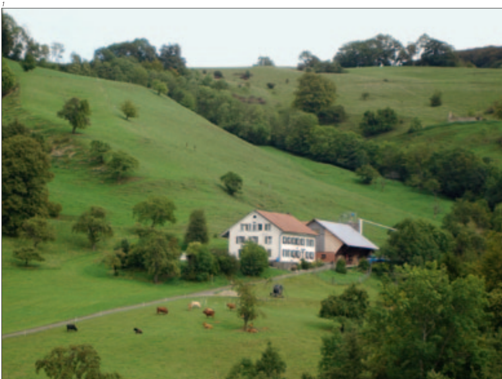
Abb. 1 Wisen, Sennhof. Die Solaranlage wurde nicht auf dem architekturhistorisch bedeutenden Wohngebäude aus dem 19. Jahrhundert, sondern auf dem Nebengebäude montiert.
