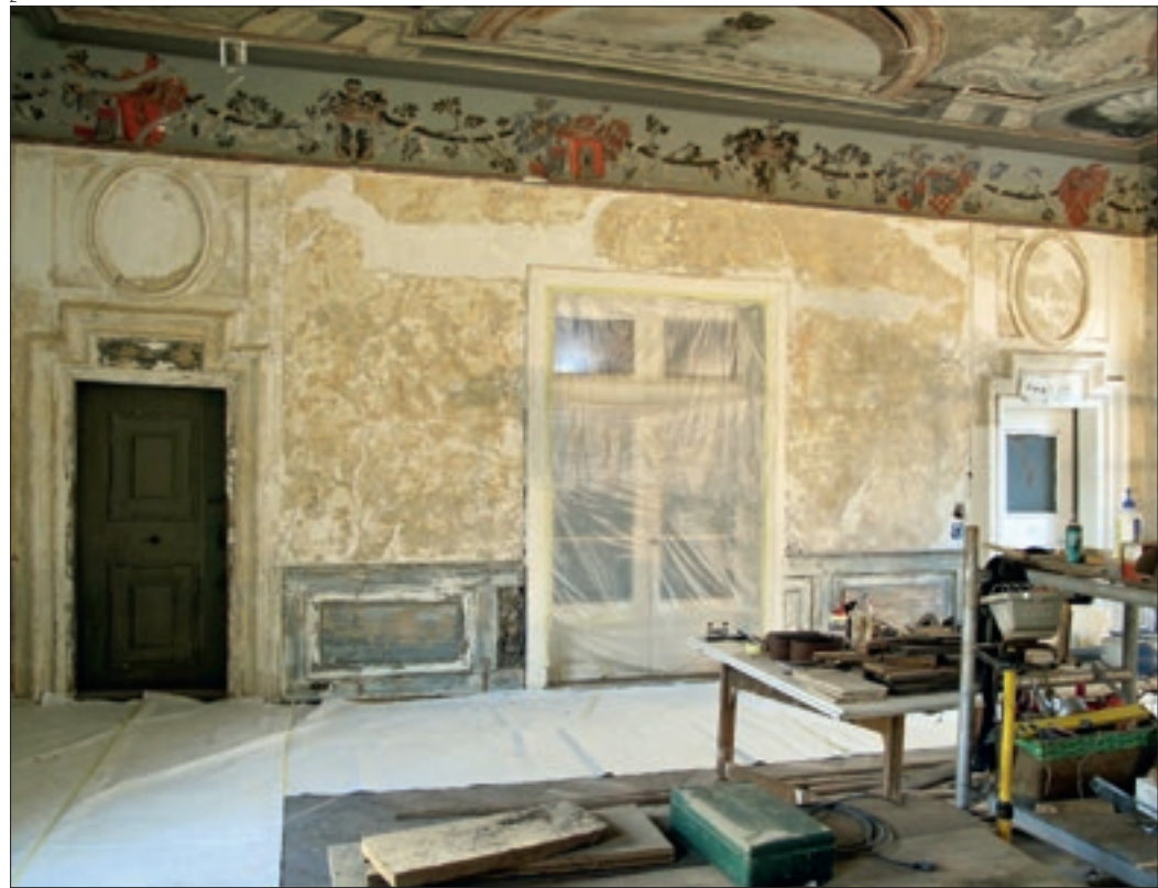
Abb. 2 Solothurn, Hauptgasse 69, Fideikommisshaus von Roll. Rittersaal während der Restaurierung 2012.
