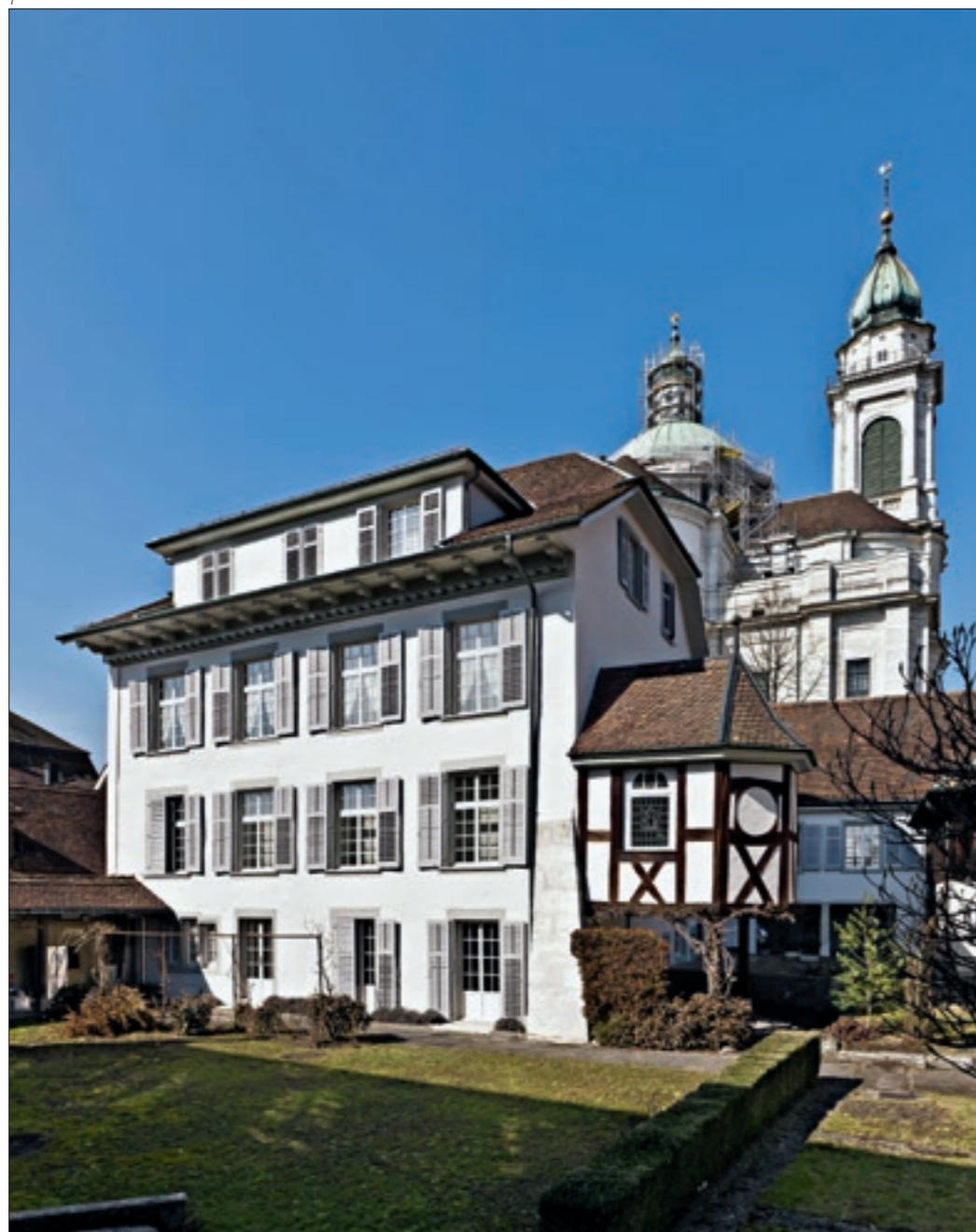
Abb. 1 Solothurn, Propsteigasse 10, Pfarrhaus St. Ursen. Ansicht von Südosten nach der Fassaden- restaurierung von 2010/11. In der Bildmitte die auf Holz- stützen stehende und in Fach- werk konstruierte Hauskapelle von 1668.
