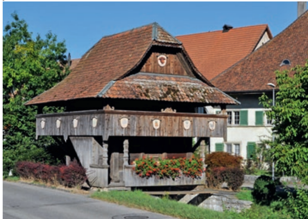
Abb. 2 Neuendorf, Dorfstrasse 95: Der prägnante Holzspeicher vertritt den in der Gegend verbreiteten Bautyp des Bachspeichers.
