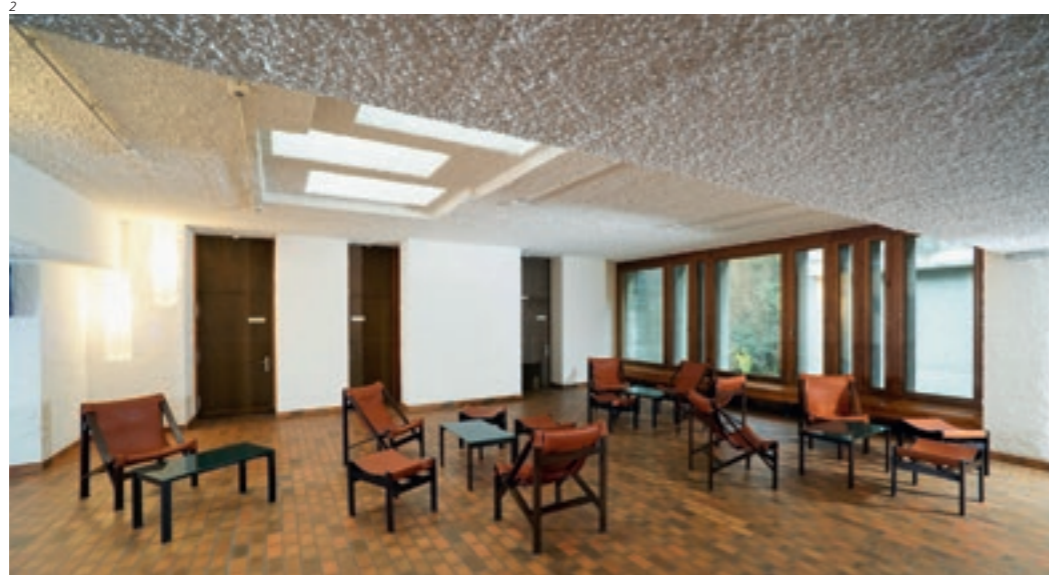
Abb. 3 Die für die Bauzeit charakteristisch rauen Putzoberflächen im Bereich des Kreuzgangs nach der Restaurierung. Foto 2012.
