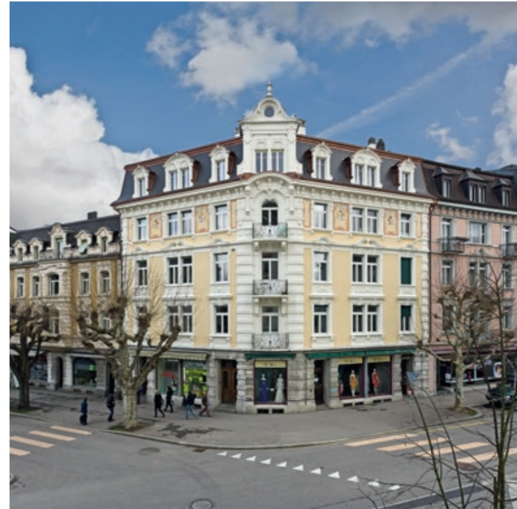
Foto: Kant. Denkmalpflege, Guido Schenker.
