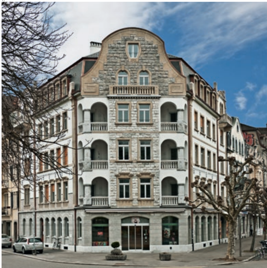
Abb. 12 Schänzlistrasse 2. Westfassade. Zustand nach der Restaurie- rung 2011.
