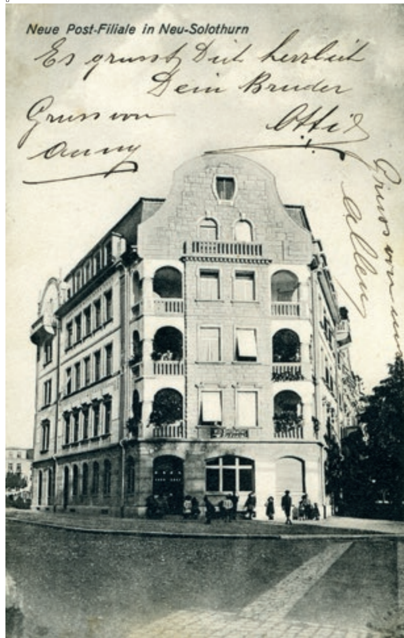
Abb. 8 Schänzlistrasse 2. Das fertig erstellte Eckgebäude mit Post- filiale im Erdgeschoss auf einer Postkarte von 1910 (Postkar- tensammlung Zentralbibliothek Solothurn, P 05180).
