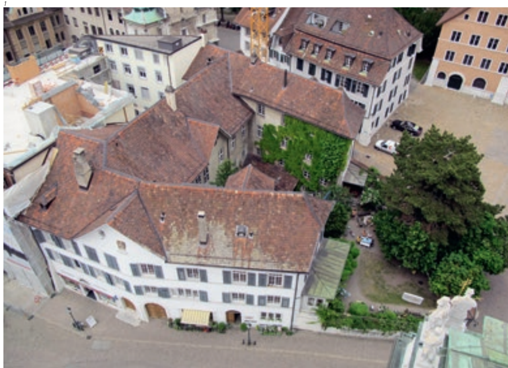
Abb. 1 Solothurn, Hauptgasse 69, Stadthaus von Roll. Blick vom Fassadengerüst der St.-Ursen- Kathedrale auf das Stadthaus von Roll, das in seiner Gesamt- anlage gut erkennbar ist. Die repräsentativen Haupträume befinden sich im nord-süd- verlaufenden (von oben nach unten) Gebäudeflügel.
