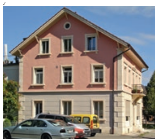
Foto: Kant. Denkmalpflege, Markus Schmid.
