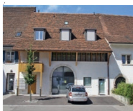
Foto: Kant. Denkmalpflege, Markus Schmid.
