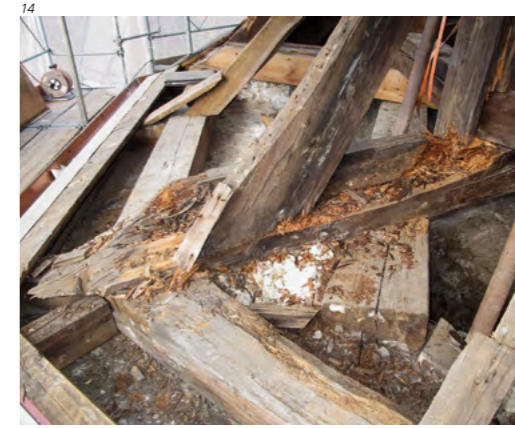
Abb. 14 Schäden an der Holzschwelle des Dachstuhls, entstanden durch eindringendes Wasser. Das Turmdach drohte gegen Westen abzuknicken.
