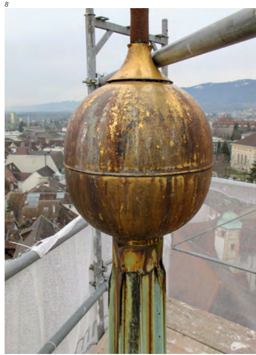
Abb. 8–13 Zustand des Kupferblechs von 1925 mit korrodierten Stellen, Ausbesserungen aus verschiedenen Zeiten, Rissen im Blech, Schäden an der Kugelvergoldung und verrosteter Wetterfahne. Foto 2015.
