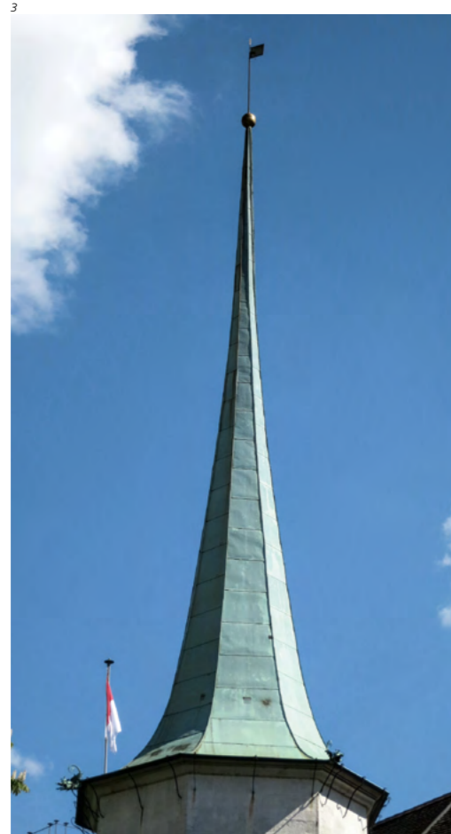
Abb. 4 Das neue Dach des Spitzhelms mit vorpatiniertem Kupfer- blech. Die Einteilung der Kupferbahnen wurde vom Vorgängerdach übernommen (vergleiche Abb. 3).
