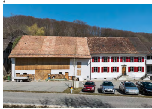
Abb. 8 Hauenstein-Ifenthal, Hauptstrasse 10. Das ehemalige Gasthaus Löwen in Hauenstein nach der Restaurierung. Foto 2016.
