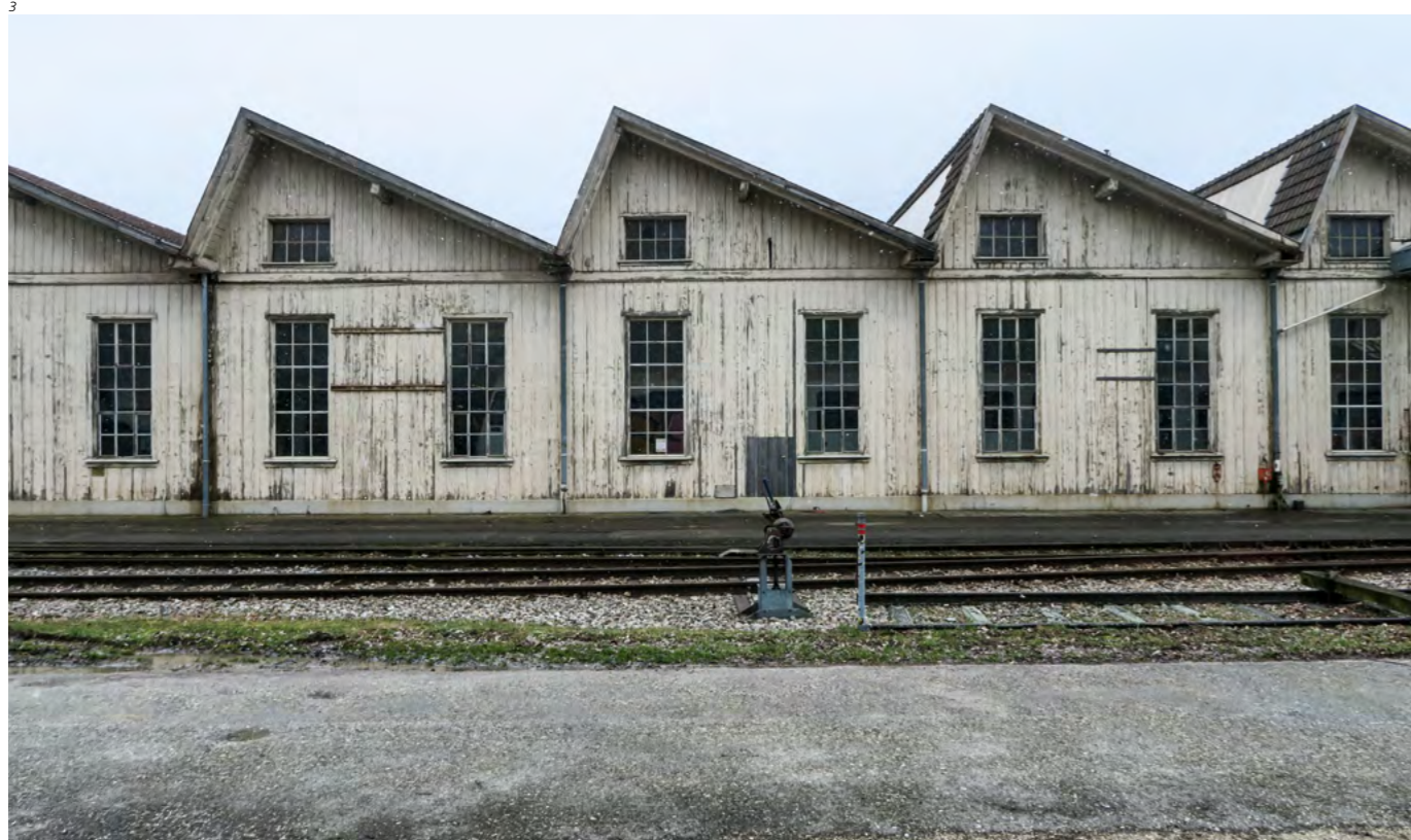
Abb. 3 Industrie- und Bahnbauten finden ebenso Eingang in den Kunstdenkmälerband Olten. Die Reparaturwerkstätten der SBB an der Gösgerstrasse, hier in einer Detailaufnahme von 2018, vertreten eine wichtige Phase aus der Frühzeit des Schweizer Eisenbahnbaus.
