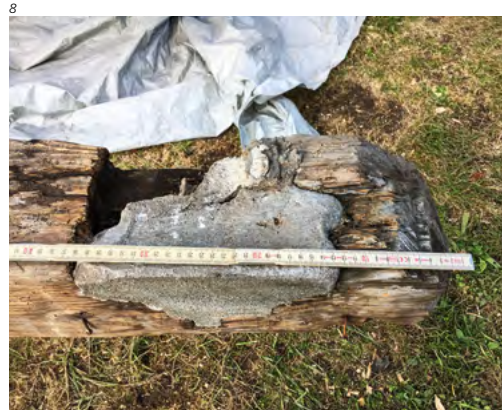
Abb. 8–11 Eckverbindung im Vorzustand mit Betonflick und unsere Reparatur.
