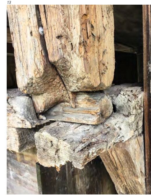
Abb. 13–15 Vorzustand und Reparatur der umlaufenden Lauben- konstruktion.
