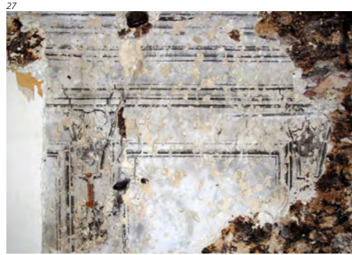
Abb. 27 Hauptgasse 56, Solothurn. Bei der Bauuntersuchung nach dem Brand 2011 gefundene, fragmentarisch erhaltene Grisaille-Architekturalereien von 1670. Foto 2011.
