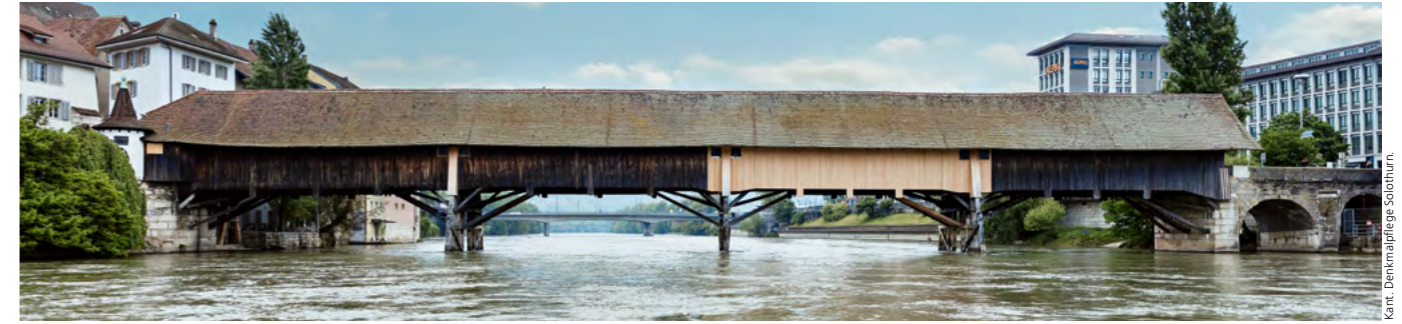
Abb. 24 Die restaurierte Holzbrücke von Süden. Foto 2020.
