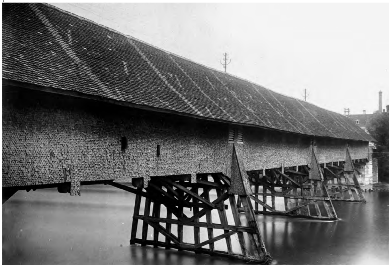
Abb. 1 Südwestansicht der Brücke mit Schindelschirm, der in der zweiten Hälfte des 20. Jahrhunderts durch eine Brettschalung ersetzt wurde. Foto um 1902.
