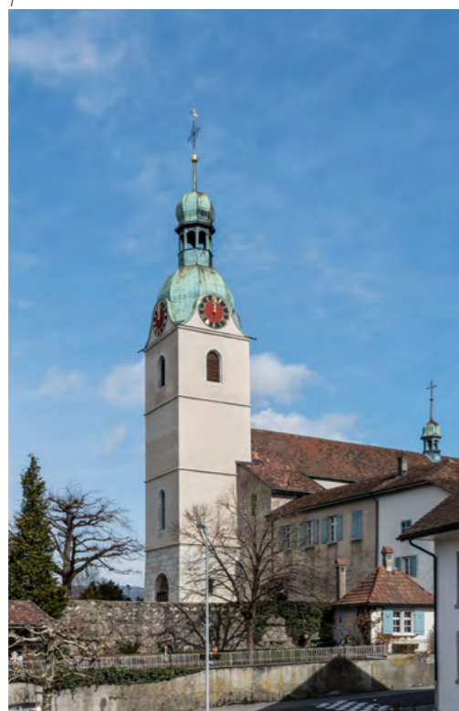
Abb. 1 Schönenwerd, Schmiedengasse 31. Der barocke Westturm der ehemaligen Stiftskirche in einer Aufnahme von 2016.
