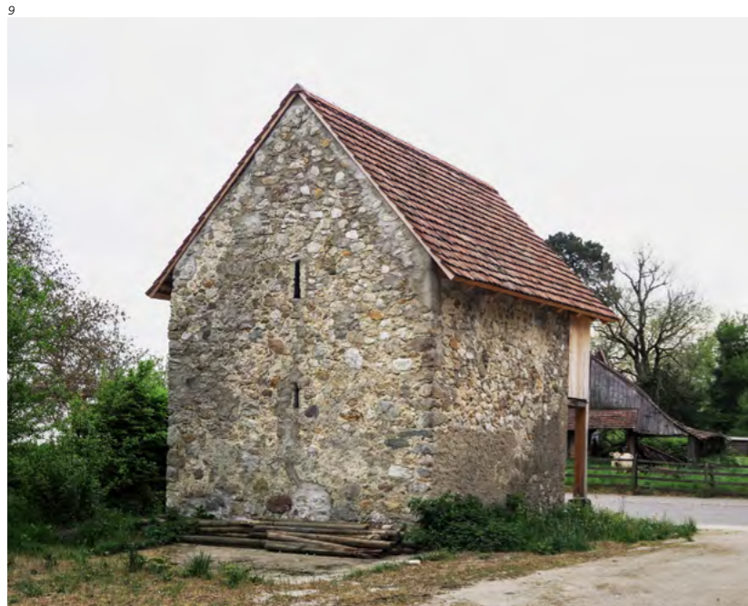
Abb. 7–9 Der Steinspeicher im Zustand nach seiner Restaurierung 2019.
