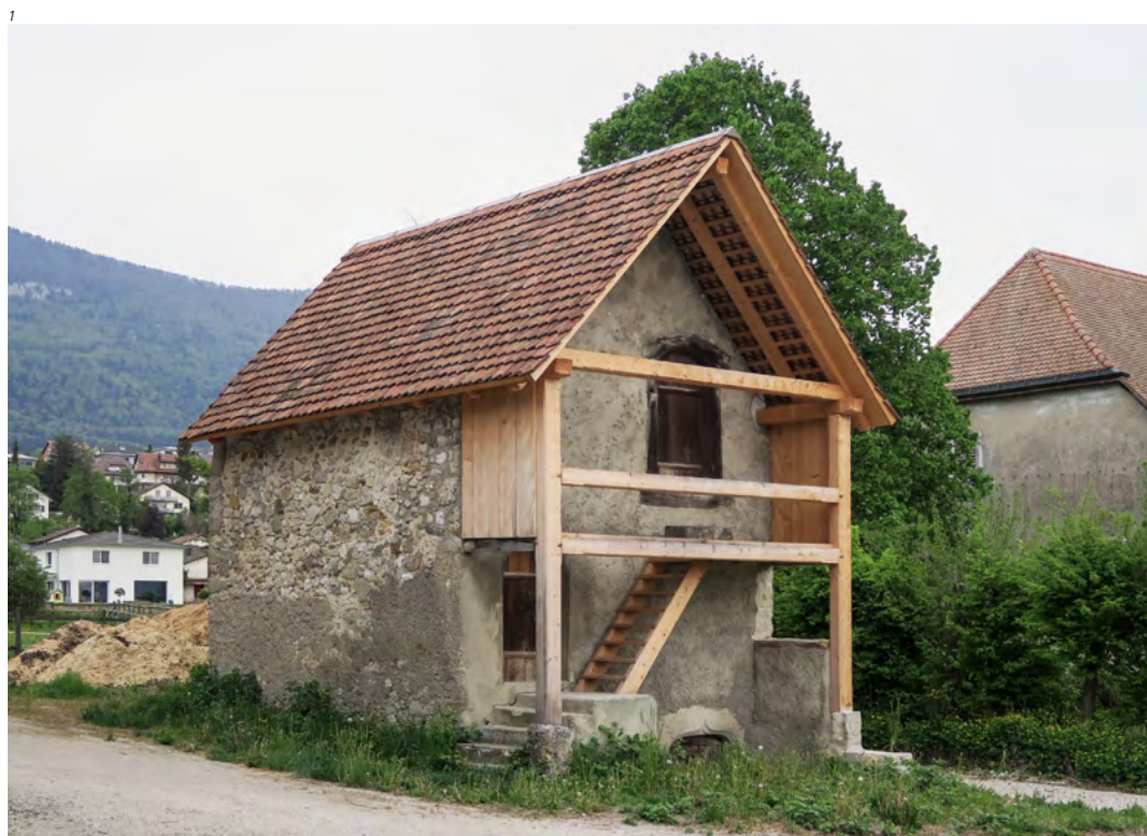
Abb. 1 Selzach, Speicher Bellacherstrasse 1b, nach der Restaurierung 2019. Die Laube wurde rekonstruiert und das Dach wiederhergestellt. Das Fassadenmauerwerk mit seinen älteren Verputzflicken konnte grösstenteils belassen werden. Der eingestürzte ostseitige Anbau wurde ersatzlos abgerissen.
