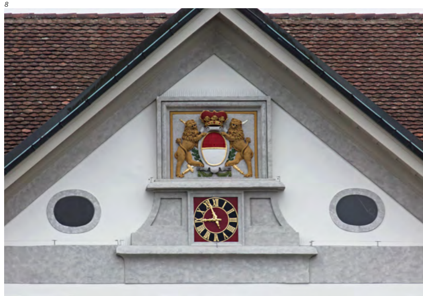
Abb. 8 Der Mittelgiebel der Innenhof- fassade im Zustand nach der Restaurierung von 2017. Die originale Farbigkeit konnte aufgrund von Befunden wiederhergestellt werden.
