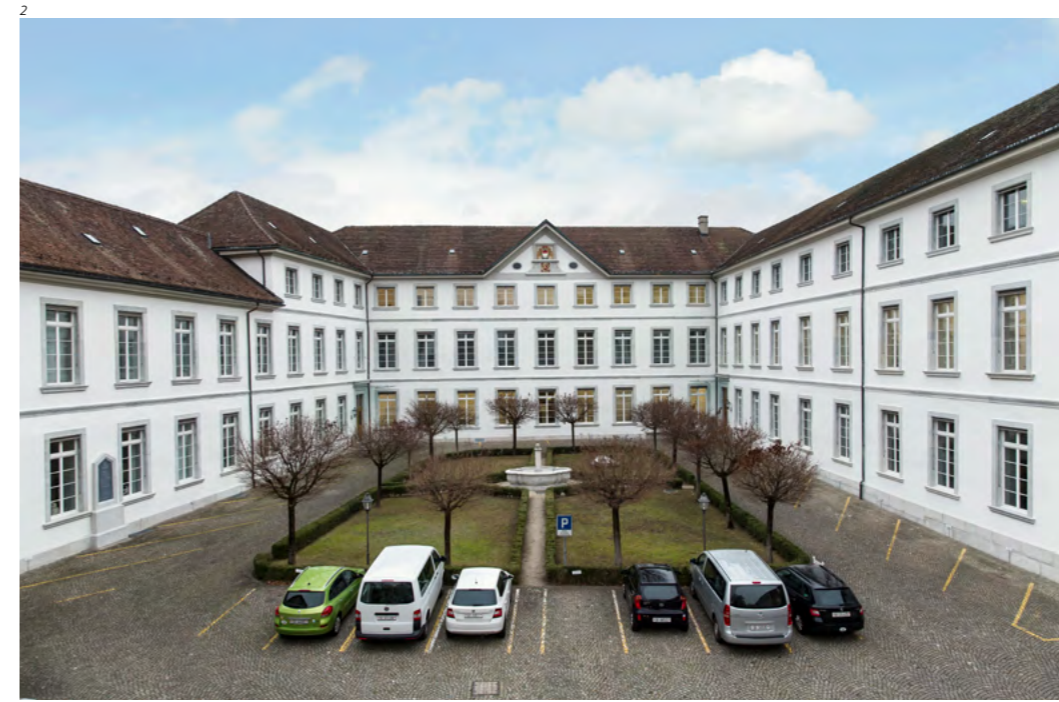
Abb. 2 Blick von Süden auf die barocke Dreiflügelanlage von 1725, im Zustand nach der Fassadenrestaurierung von 2018. Durch die neue weisse Farbgebung erhielt die Fassadengliederung wieder ihre Kraft zurück.
