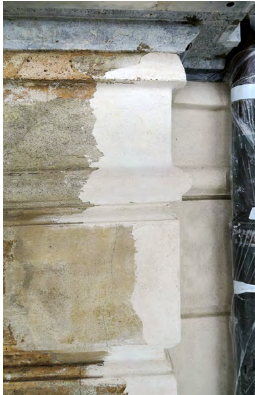
Abb. 16 und 17 Nordfassade während der Restaurierung. Neue Auf- mörtelungen von Profilen, Eckkanten und Oberflächen mit einem weichen Kalk- mörtel.
