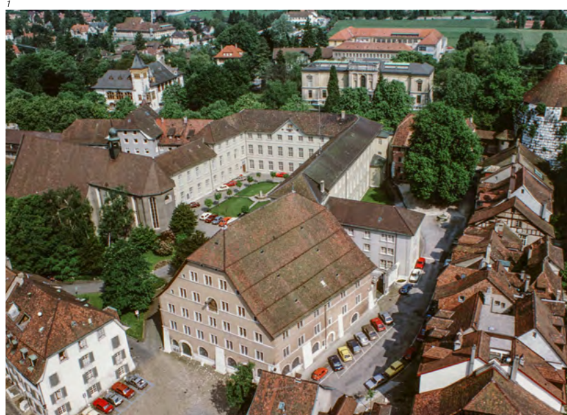
Abb. 1 Blick vom Turm der St.-Ursen-Kathedrale aus auf die U-förmige Anlage des Ambassadorshofs, Foto 1983. Im Vordergrund liegt der mächtige Baukörper des Alten Zeughauses. Links schliesst die Franziskanerkirche an den Ambassadorshof an. Nordseitig liegt der Stadtpark mit Kunstmuseum und Konzertsaal.
