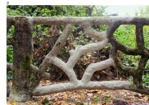
Abb. 8 Rüttenen, Waldpark Wengistein, Detail des Zementgeländers beim Känzeli nach der Restaurierung 2019.
