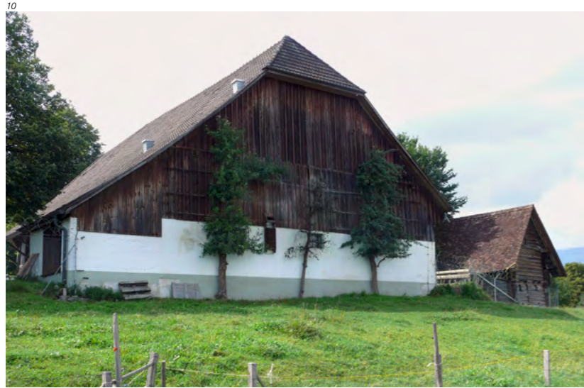
Abb. 10 Schöngrün, Stallscheune. Ansicht von Südosten. Dahinter der Speicher. Zustand 2016.
