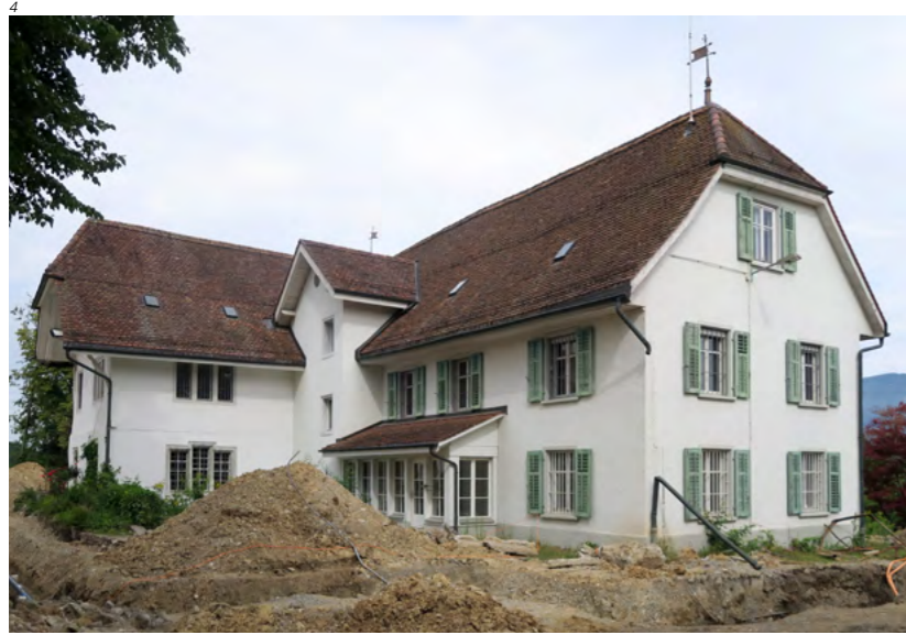
Abb. 4 Schöngrün, Hauptgebäude. Ansicht von Osten, Zustand 2019.
