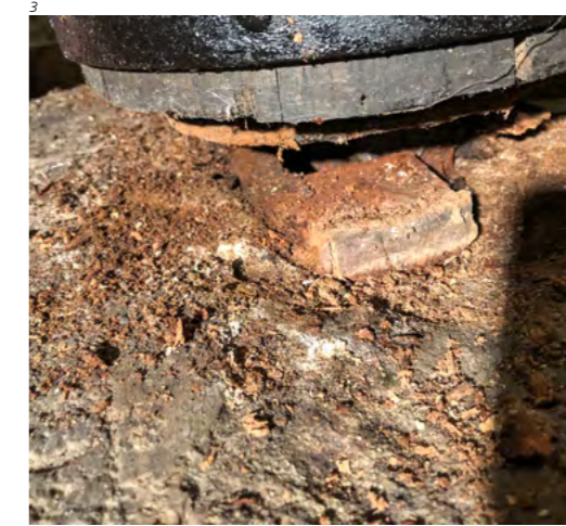
Abb. 2 Korbrad am Wellbaum des Kollerganges. Die Stege sind durch Abnutzung und Zerfall geschädigt.
