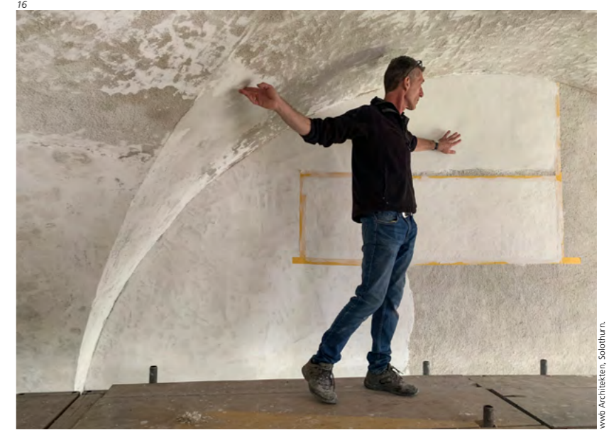
Abb. 15 und 16 Gewölbe der Vorhalle. Links: Feuchtigkeitsschäden vor der Restaurierung, Foto 2017. Rechts: Während der Restaurierung des Gewölbeverputzes, Foto 2020.
