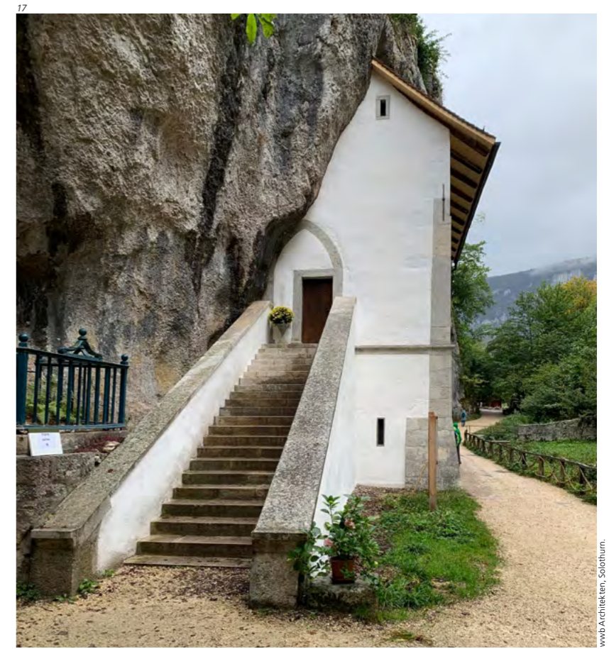
Abb. 17 Verenakapelle mit restaurierter Fassade, regelmässig gestalteten Ecklisenen und neuer Kellerluke zur besseren Durchlüftung. Foto 2020.
