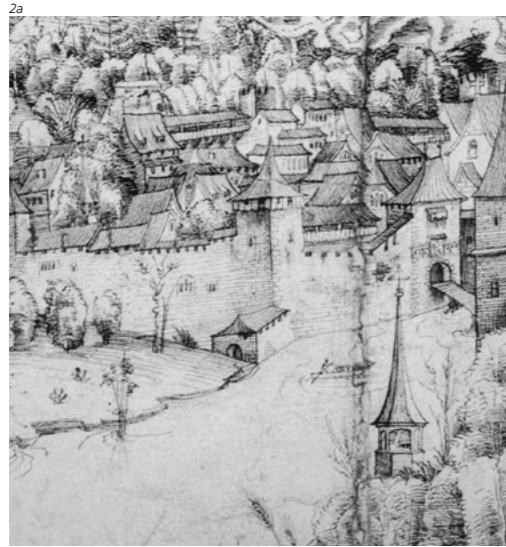
Abb. 2 Die Südwestecke der Solothurner Altstadt mit den verschiedenen Elementen der Stadtbefestigungen. a Spätmittelalterliche Stadtmauer mit Haffners-Turm und Stadtgraben, Federzeichnung von Urs Graf, um 1508; b frühneuzeitlicher Katzensteg-Turm mit Stadtgraben und Gegenmauer, Holzschnitt von Ch. Simmler in Sebastian Münters Cosmographie, 1553; c barocke St.-Georgs-Bastion, Graben und Vorwerk, kolorierte Federzeichnung von Johann Baptist Altermatt, 1833.
