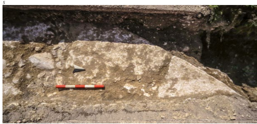
Abb. 5 Angeschnittene Mauer M2 des frühneuzeitlichen Katzenstegturms. Gegen Westen.
