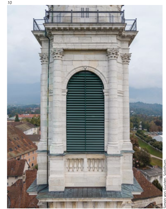
Abb. 10 Solothurn, Turm der St.-Urnen- Kathedrale. Ansicht der Glockenstube nach der Erneue- rung der Jalousien.
