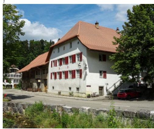
Abb. 1 Beinwil, Scheune und Gasthaus zum Reh, Passwangstrasse 69. Südansicht nach der Dachsanieierung von 2021.
