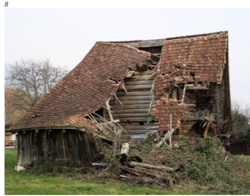
Abb. 8 Selzach, der Kornspeicher Bellacherstrasse 1c in einer Auf- nahme von 2019.
